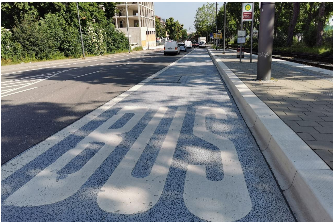
Abbildung 23: Musterhaltestelle Bus (Beispiel: Haltestelle Thüringenhalle)
