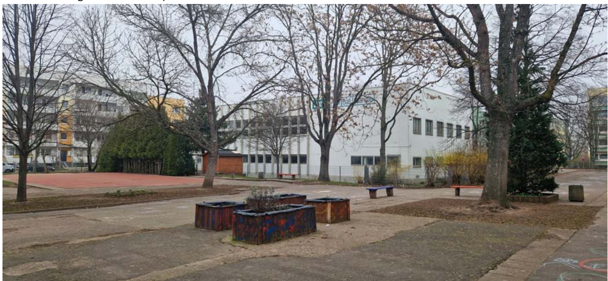
Schulhof auf der Westseite
