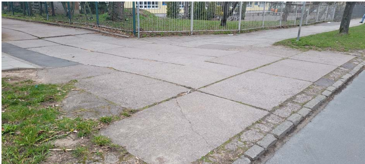
Zufahrt zum rückwärtigen Schulgebäude von der Warschauer Straße abzweigend
