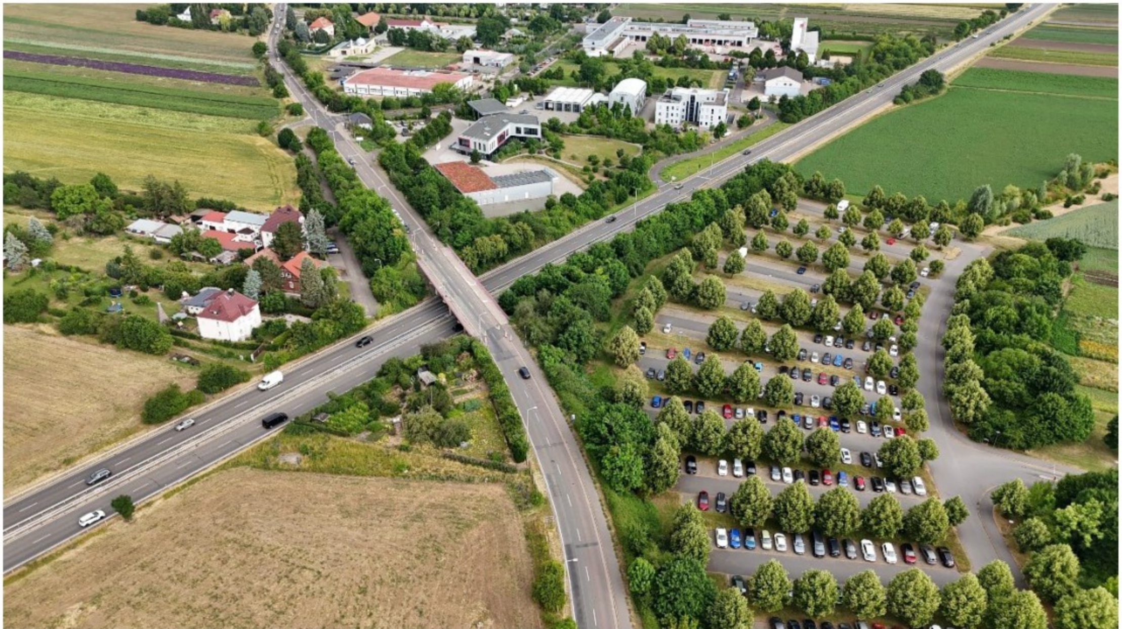
BW153_ Brücke Schwarzburger Straße_Bestandssituation
