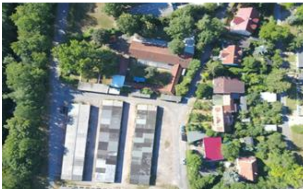
Abb. 15 – Luftbildaufnahme ehemaliger Garagenhof nördlich der Radrennbahn vor der Um- und Neugestaltung im Rahmen derBUGA
