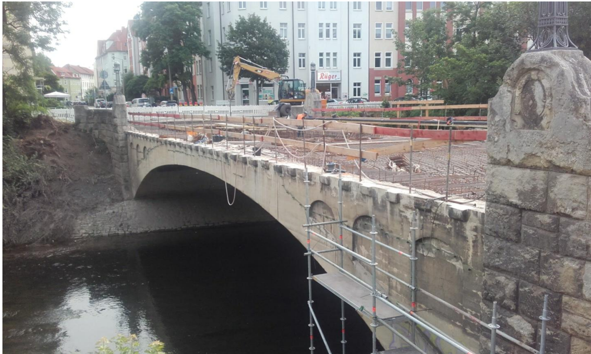
Abb. 12 - Karlsbrücke während der Sanierung
