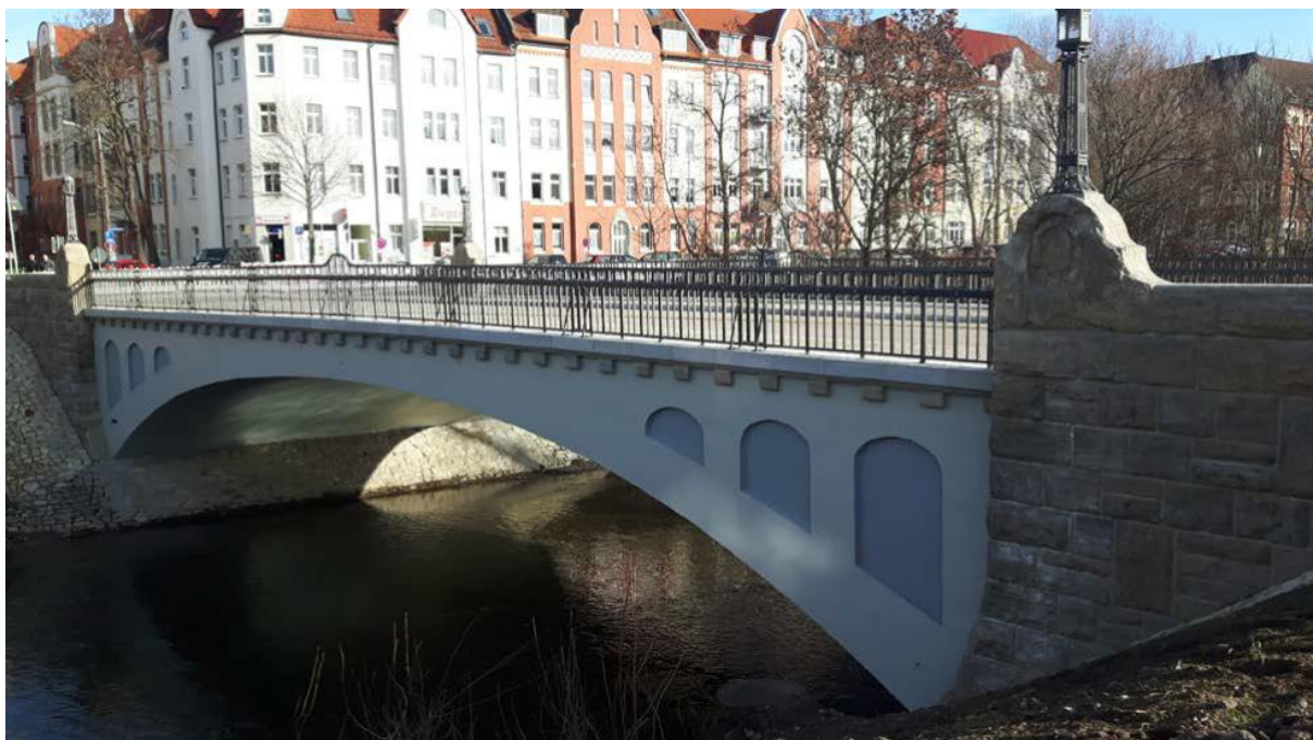
Abb. 13 - Karlsbrücke nach umfassender Sanierung
