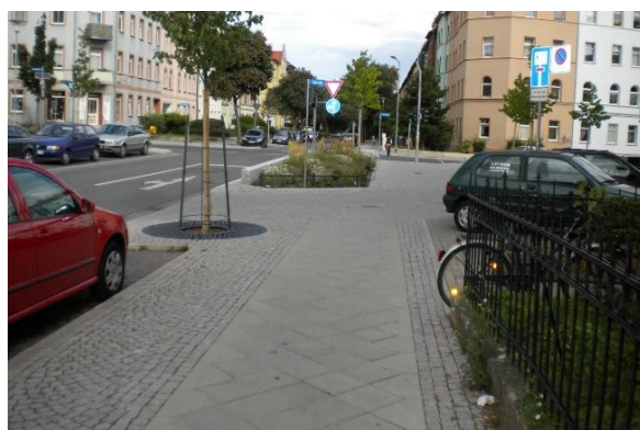
Abb. 10 - Auenstraße - Talstraße / Blick nach Nordwesten / Neugestalteter Straßenraum und Platzbereich
