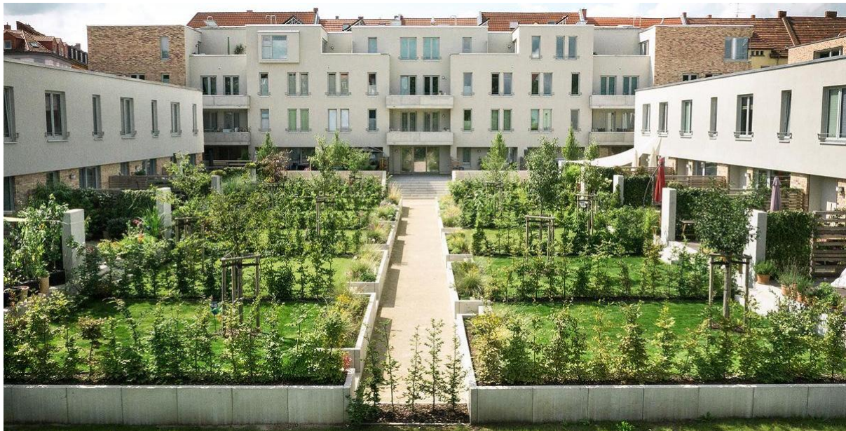
Abb. 08 - Bestandsfoto Sanierungsgebiet Auenstraße / Nordhäuser Straße – Neubebauung "Wohnen an der Adalbertstraße"
