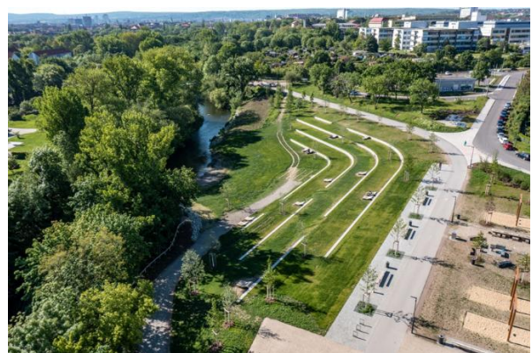
Abb. 19 - Luftbildaufnahme Sanierung im Bereich der BUGA - Maßnahme M 6 / Neuer Park an der ehemaligen Kläranlage in der nördlichen Geraue nach Fertigstellung
