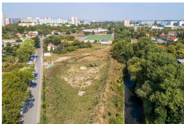
Abb. 18 – Luftbildaufnahme Sanierung im Bereich der BUGA - Maßnahme M 6 / Brachfläche der ehemaligen Kläranlage in der nördlichen Geraue vor der Um- und Neugestaltung
