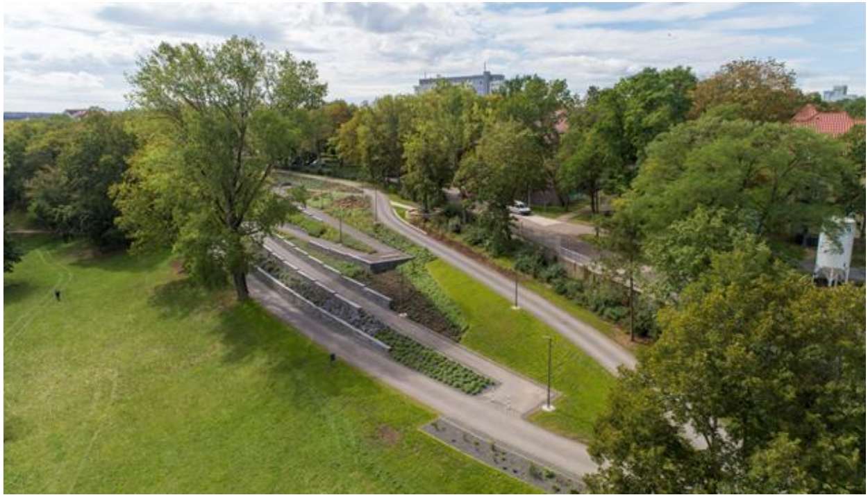
Abb. 26 - Luftbild: Nordparkfläche – Barrierefreier Zugang von der Baumerstraße zum Nordpark - nach der Um- und Neugestaltung im Rahmen der BUGA
