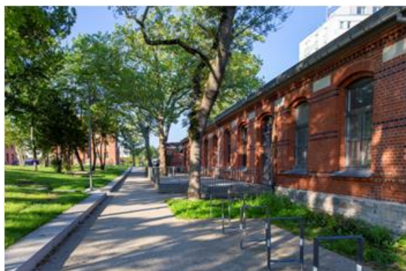
Abb. 30 - Neugestaltete Freianlagen vor dem Haus 35 / Blick nach Westen
