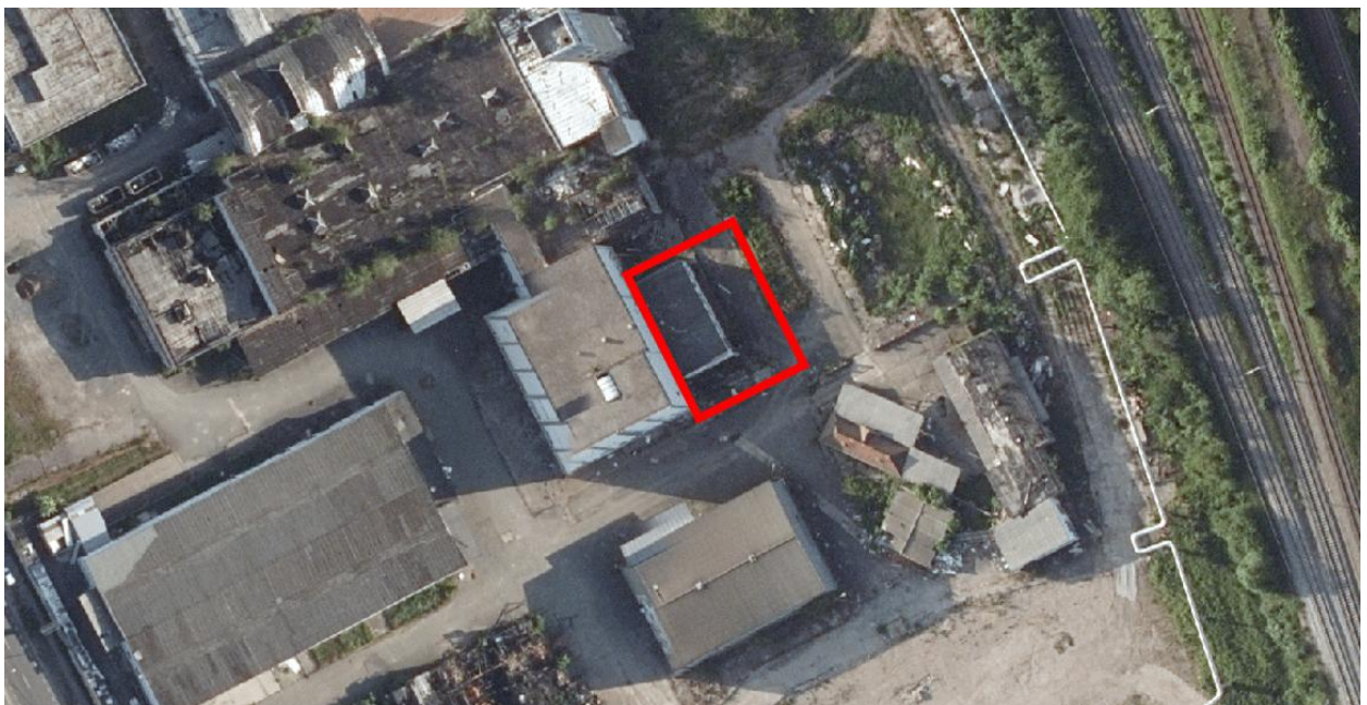
Abb. 12: unsachgemäß demontierte Trafos, Greifswalder Straße 28.
