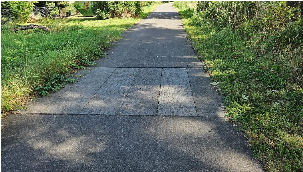
Wurzelbrücke für einen kürzeren Wegeabschnitt
