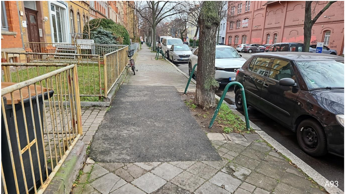
Foto 9 Liebknechtstraße Baum A93
