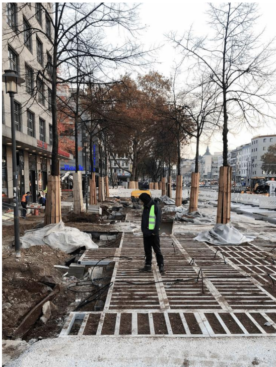
Wurzelbrückensystem mit modularer Unterkonstruktion mit punktuellen schraubfundamenten für kürzere Wegeabschnitte oder Platzflächen
