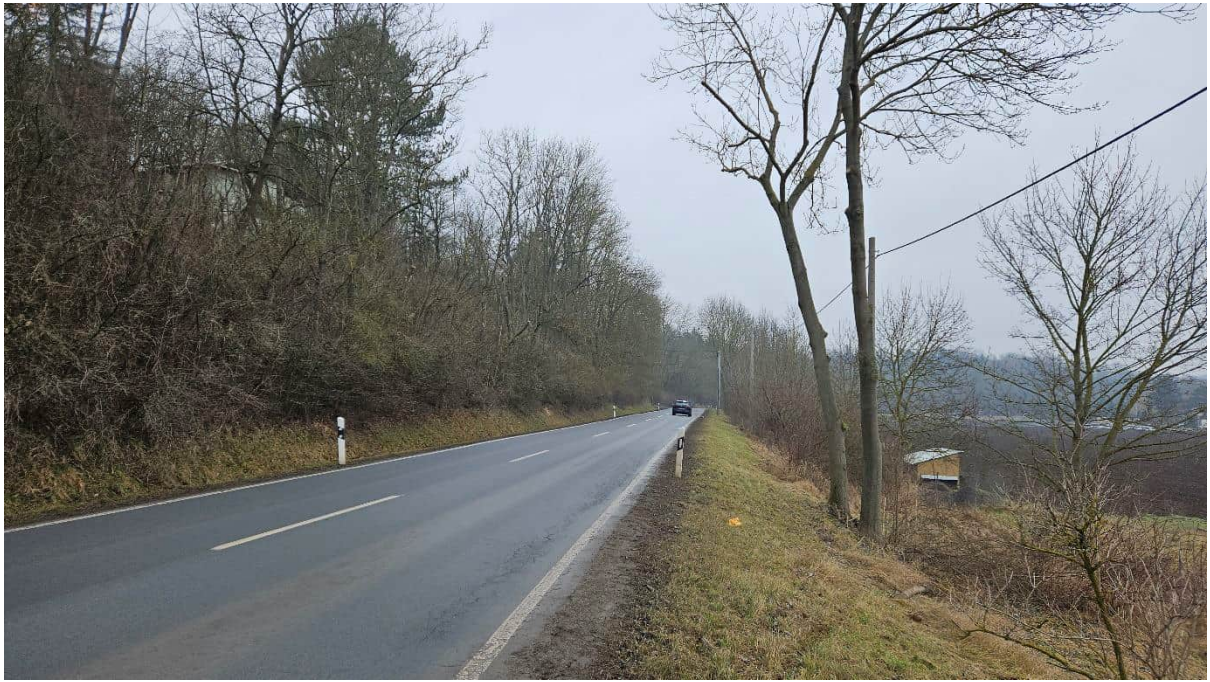
Abbildung 8 Geratalstraße, ca. Station 0+880 Blickrichtung Hochheim
