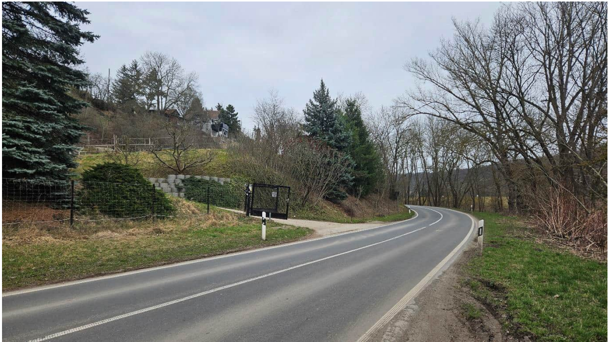
Abbildung 6 Bischleber Straße ca. Station 1+680 Blickrichtung Hochheim
