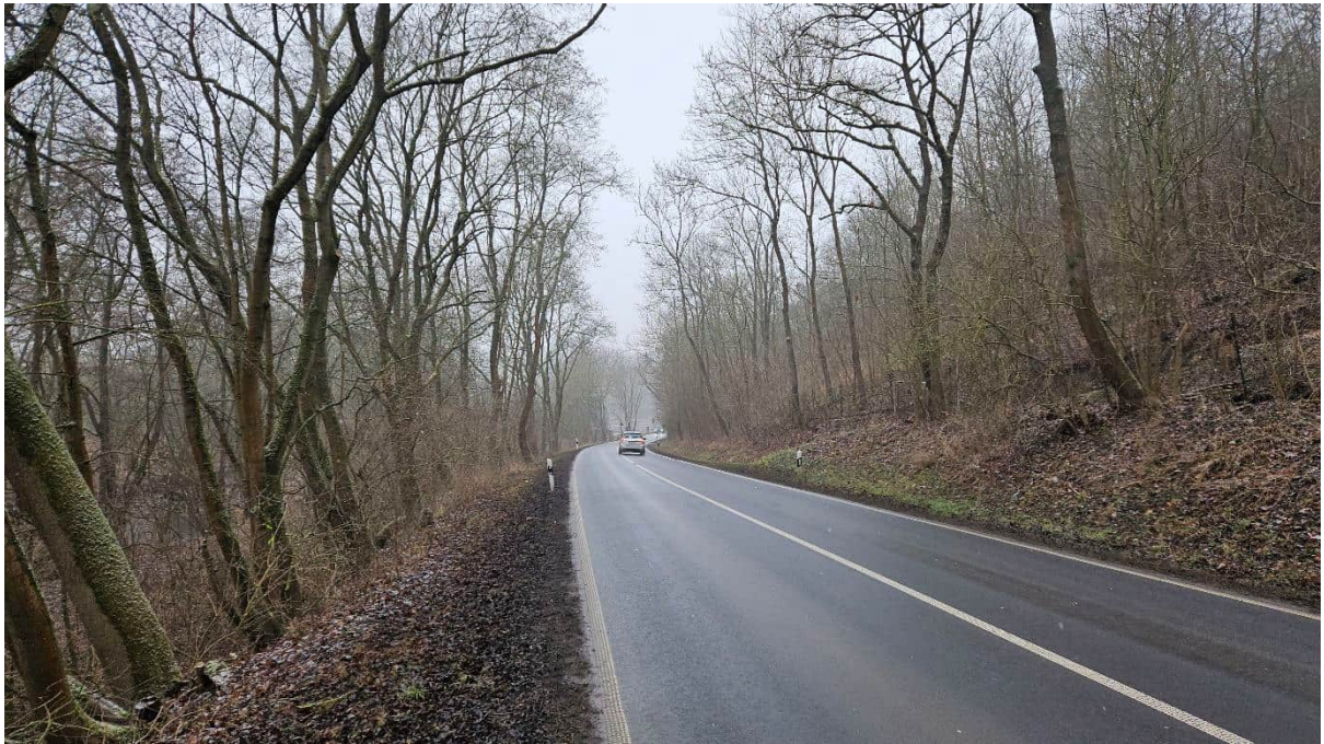
Abbildung 4 Bischlebener Straße ca. Station 1+950 Blickrichtung Bischleben
