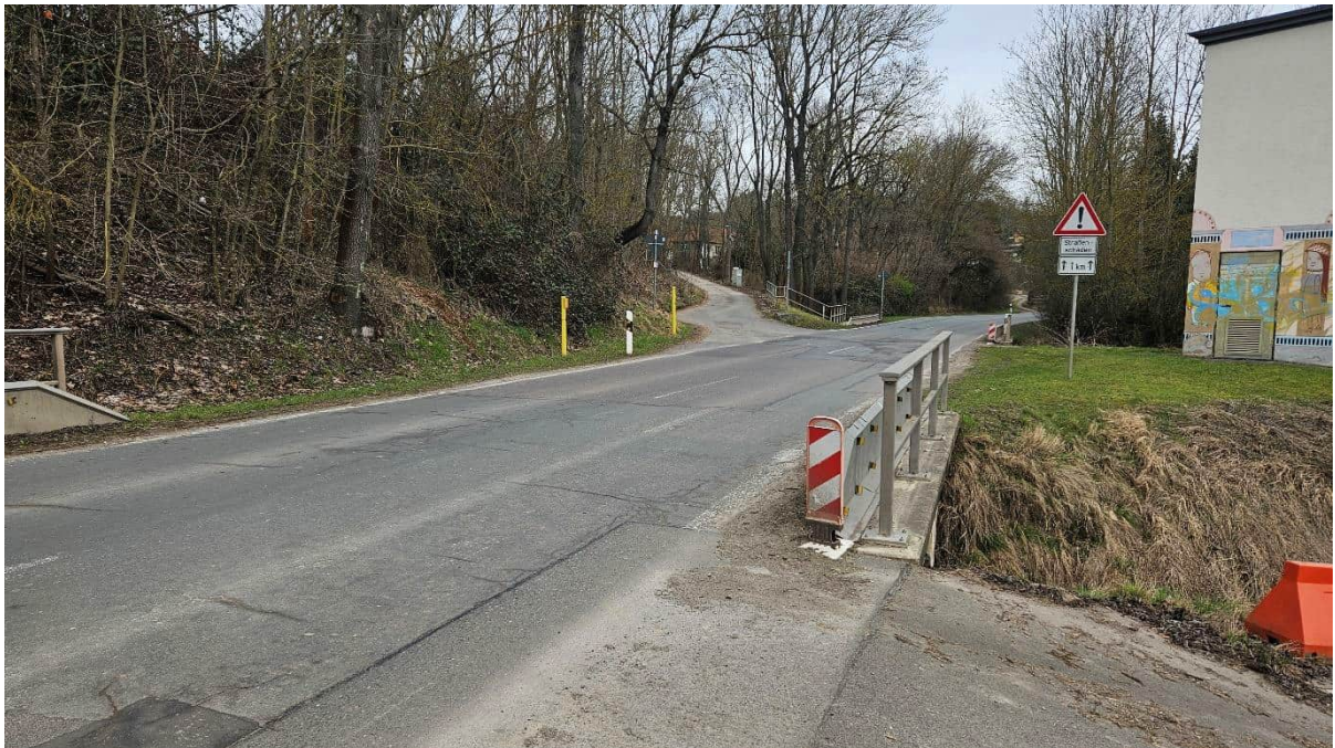
Abbildung 9 Geratalstraße Station 0+550, Blickrichtung Hochheim Im Bildvordergrund BW 109 i Bildhintergrund Zufahrt Roter Hof und BW 108.
