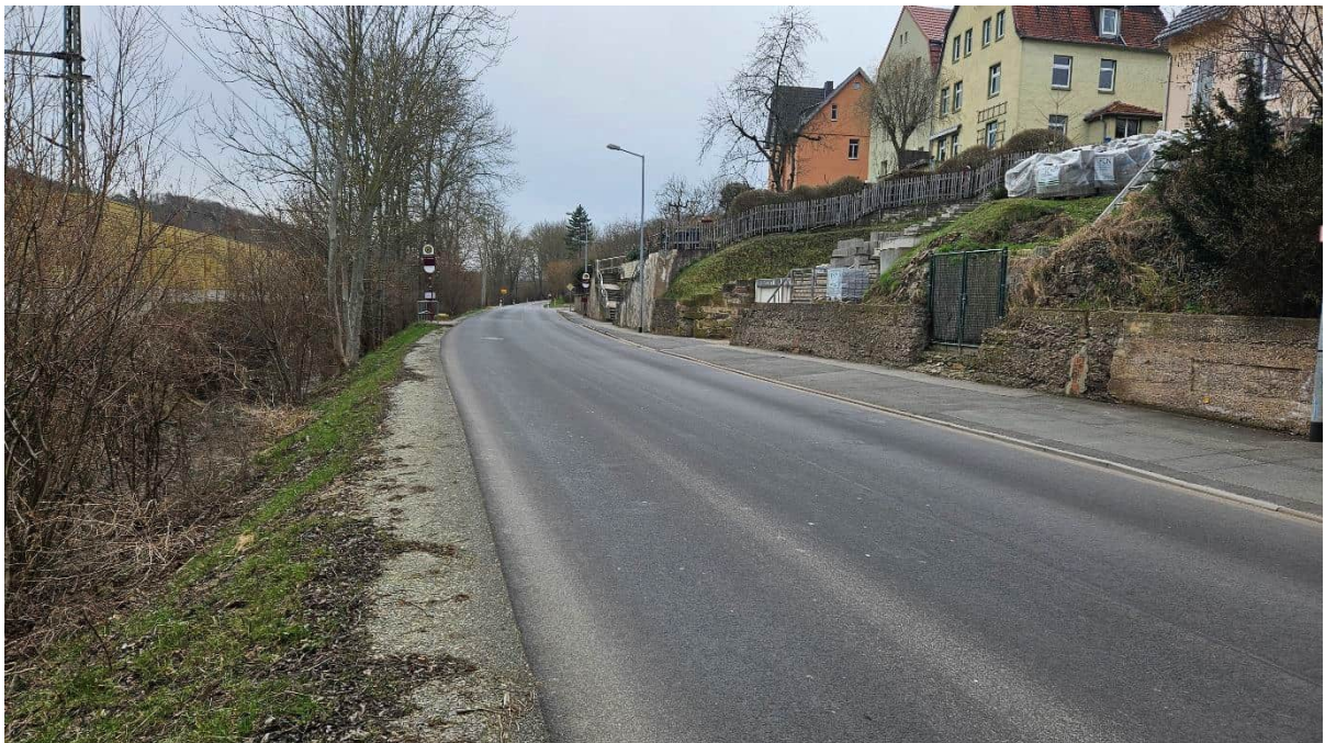
Abbildung 3 Ortsausgang Hochheim Station 2+270 Blickrichtung Bischleben
