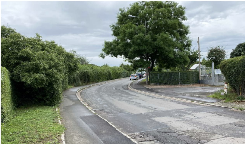
Abb. 7: vorhandene Hecke Nordseite, vorhandener Baum (A23) Südseite
