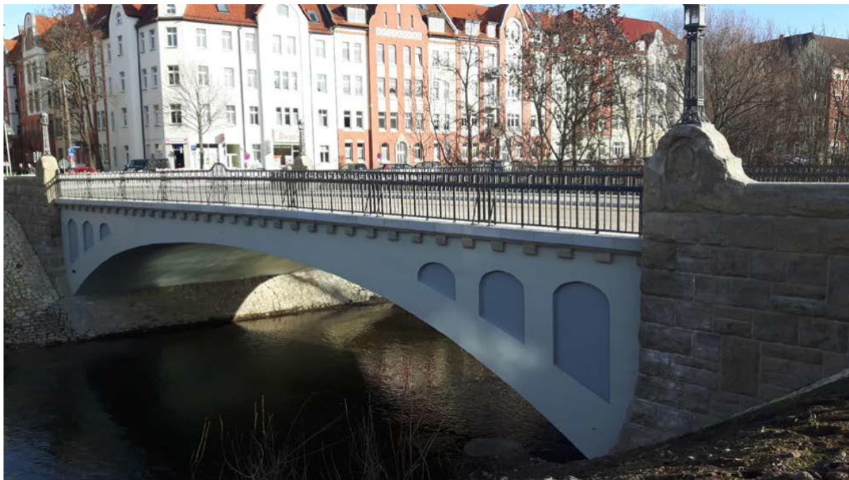
Abb. 13 - Karlsbrücke nach umfassender Sanierung
