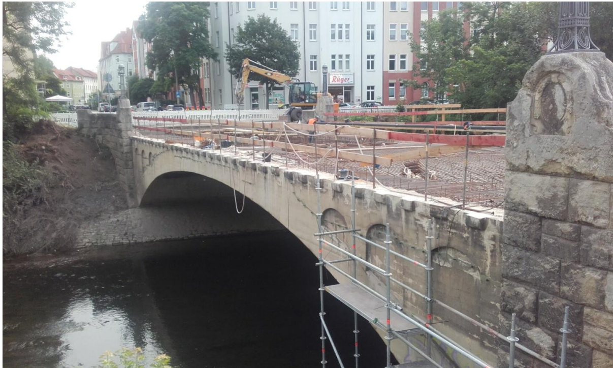
Abb. 12 - Karlsbrücke während der Sanierung
