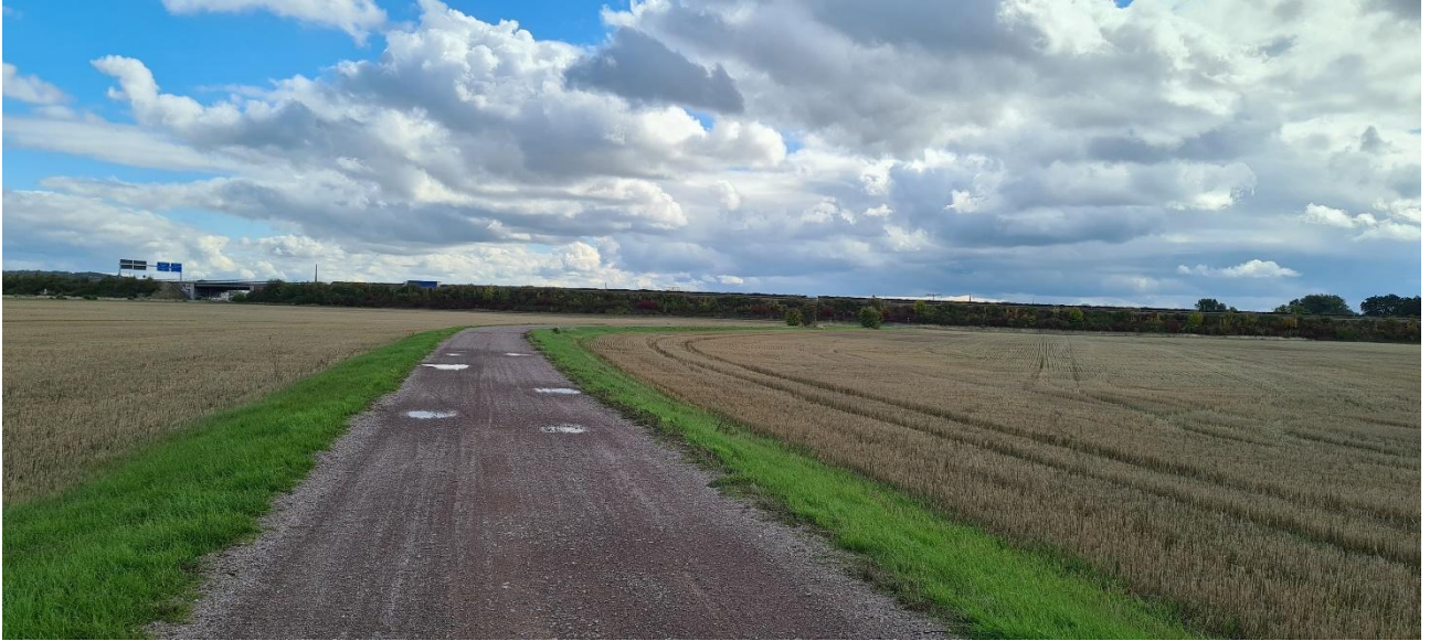
Abbildung 5 Standort Station 1+360 mit Blickrichtung Süden
