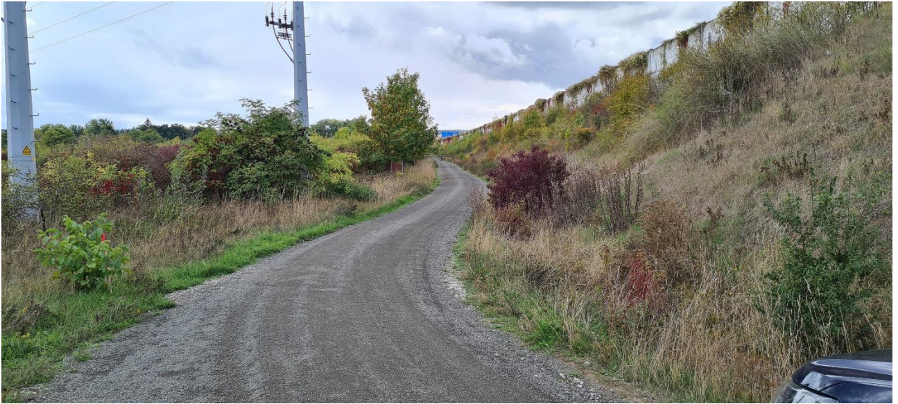
Abbildung 7 Station 0+690 mit Blickrichtung Westen
