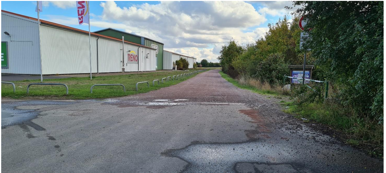
Abbildung 3 Bauende mit Blickrichtung Süden
