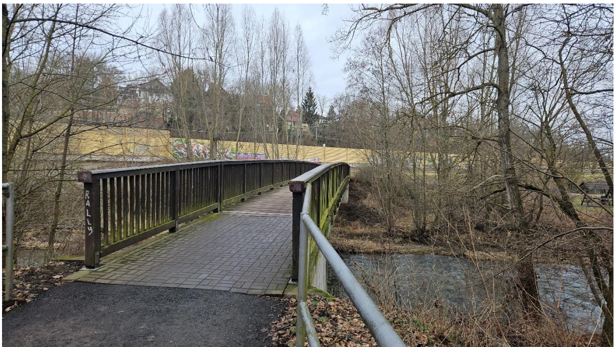
Abbildung 19 Brücke des Bachstelzenweges über die Gera Blickrichtung Norden
