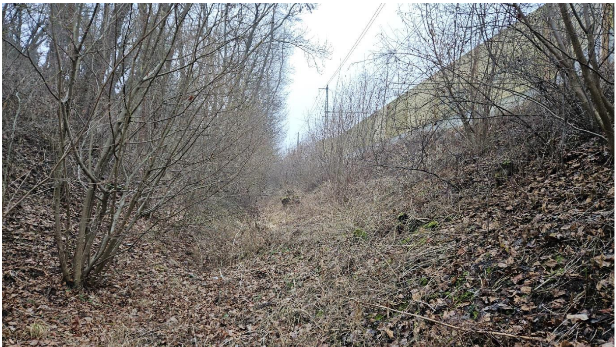
Abbildung 5 Gewässerverlauf des Mühlgrabens Hochheim Station ca. 1+750, Blickrichtung Hochheim
