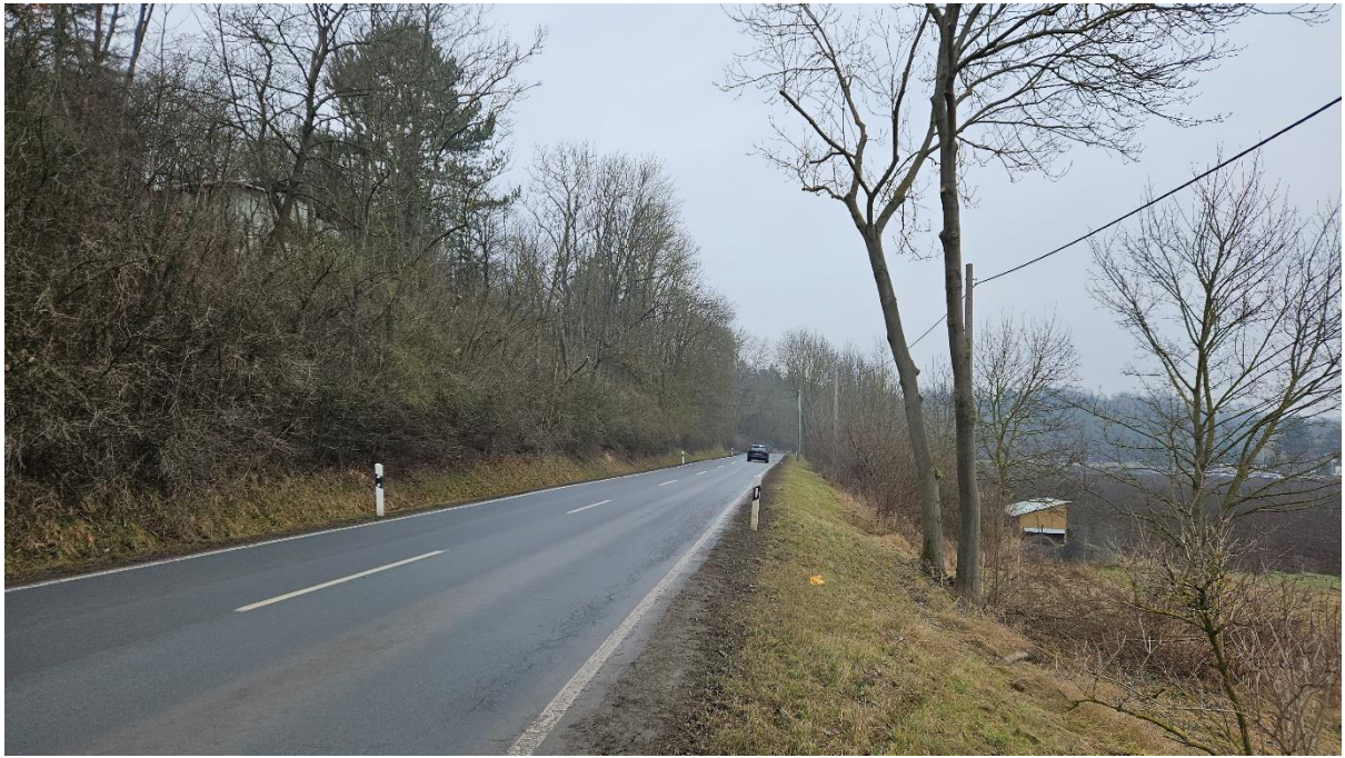
Abbildung 8 Geratalstraße, ca. Station 0+880 Blickrichtung Hochheim
