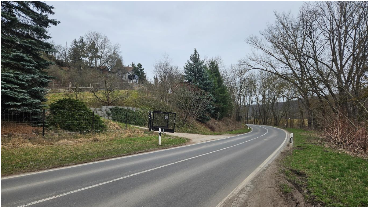
Abbildung 6 Bischleber Straße ca. Station 1+680 Blickrichtung Hochheim
