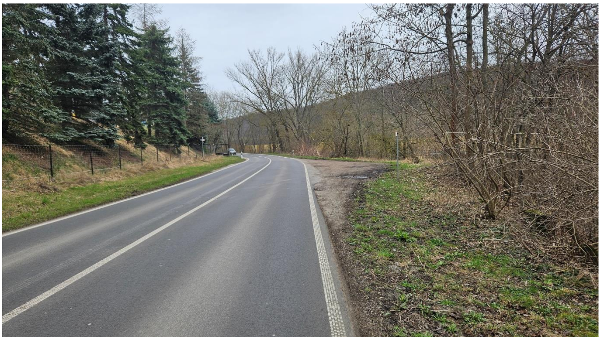
Abbildung 7 Bischleber Straße ca. Station 1+600 Blickrichtung Hochheim
