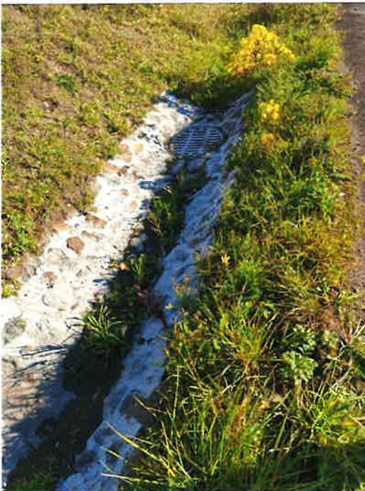
Beckenzulauf weiterführende Verrohrung
