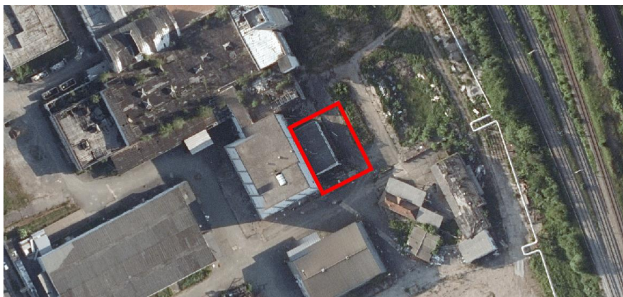
Abb. 11: unsachgemäß demontierte Trafos, Greifswalder Straße 28.
