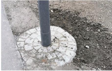
Abb. 20 Beispiel Mastumpflasterung in unbefestigten Flächen
