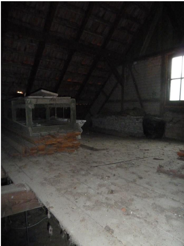
Raum 06/ „unausgebauter Dachboden“
