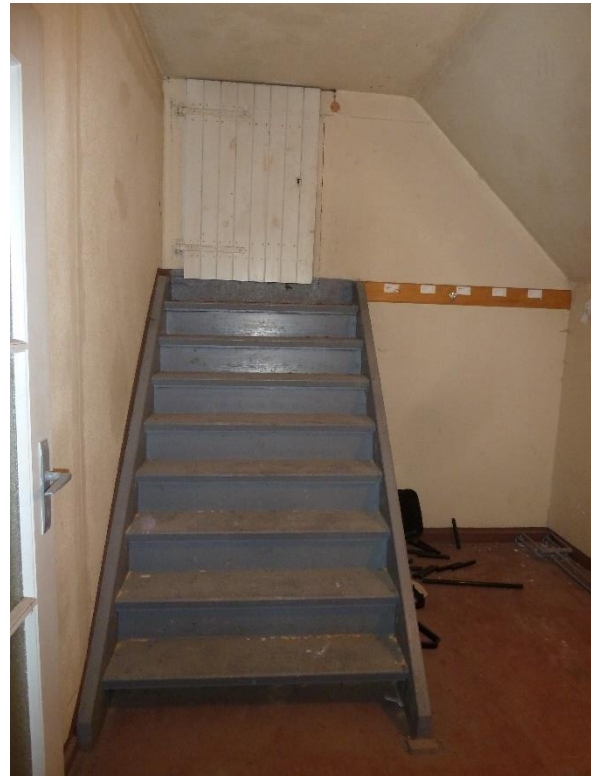
Treppe in Raum 05
