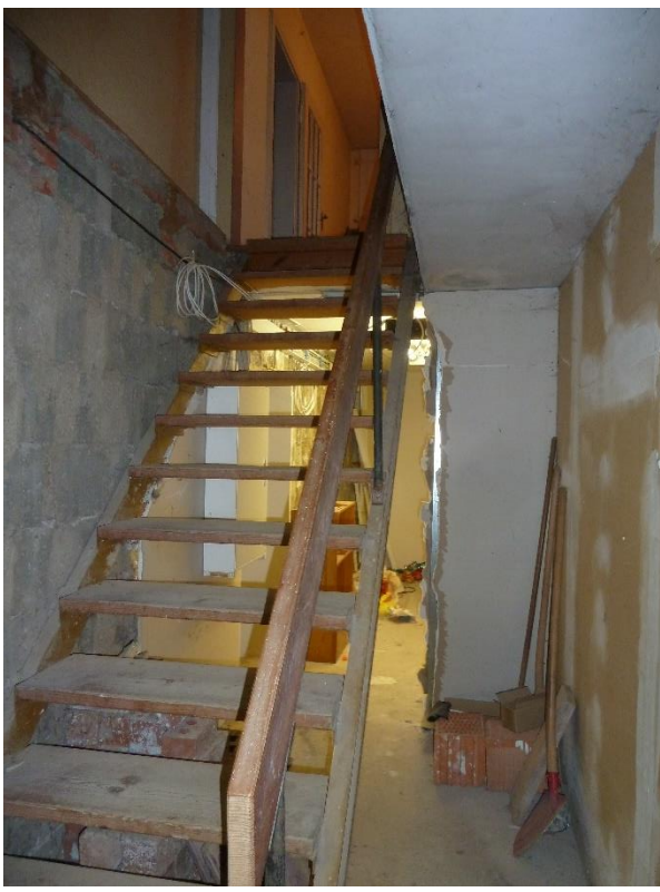
Treppe in Raum 03
