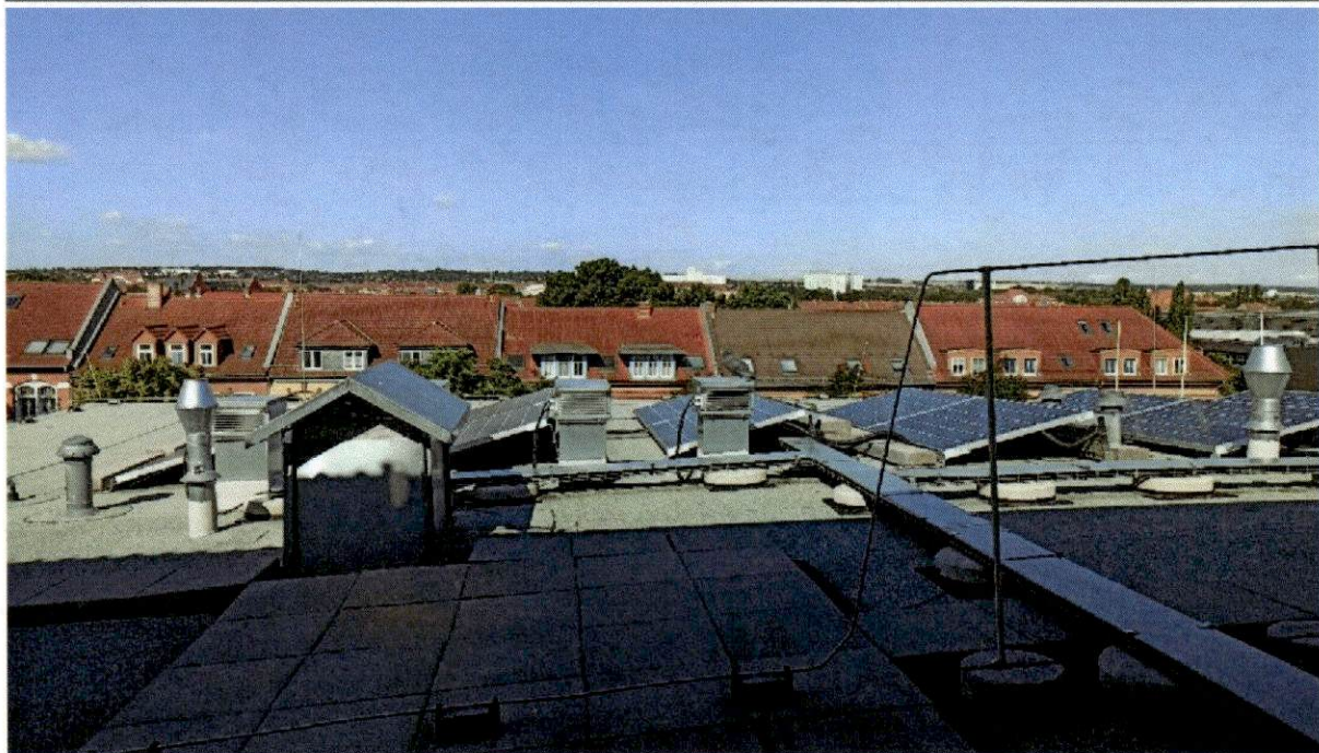
Abbildung 39 Saniertes Flachdach mit Photovoltaik-Anlage (2020)
