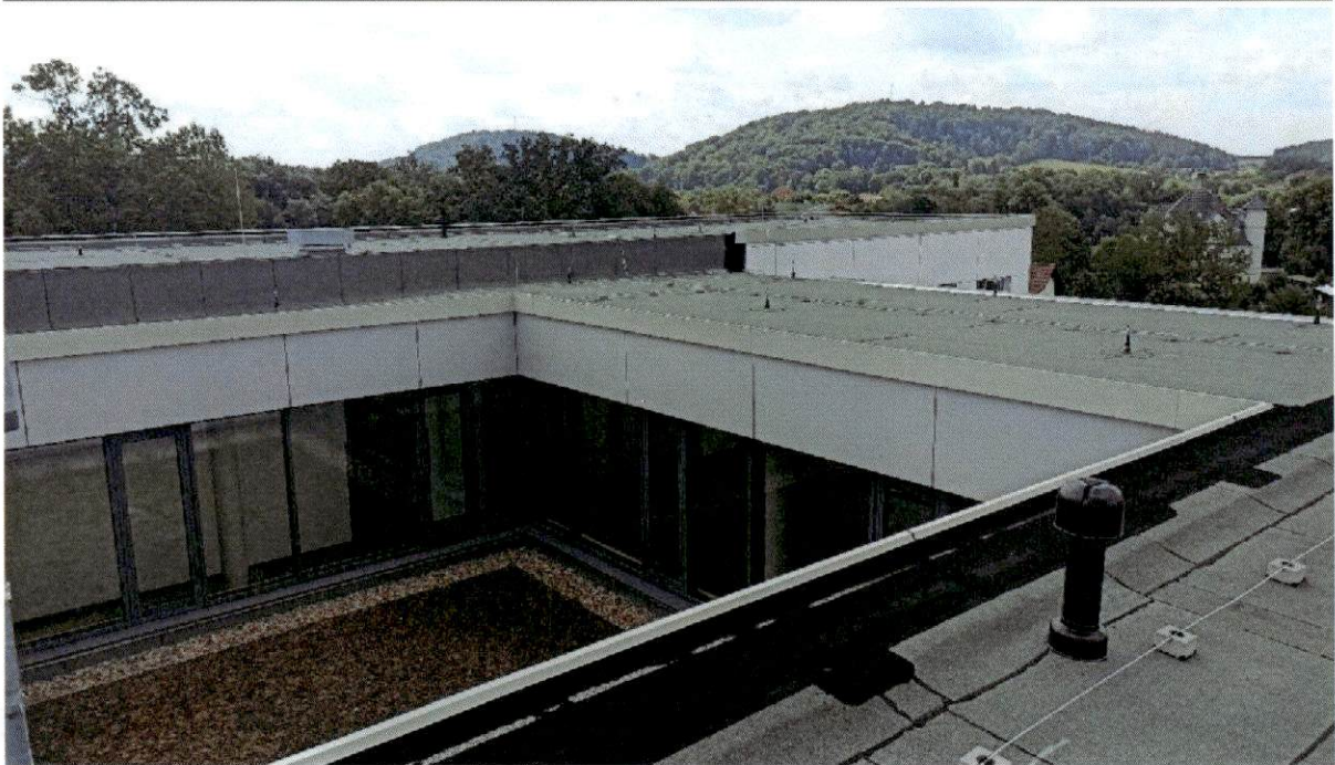
Abbildung 38 Flachdach saniertes Schulgebäude (2023)
