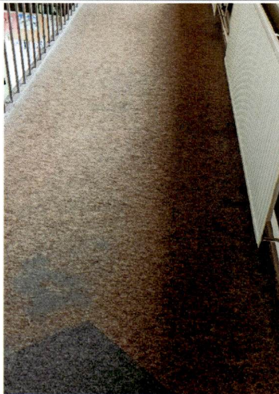
Abbildung 32 Abgenutzter Vliesboden
