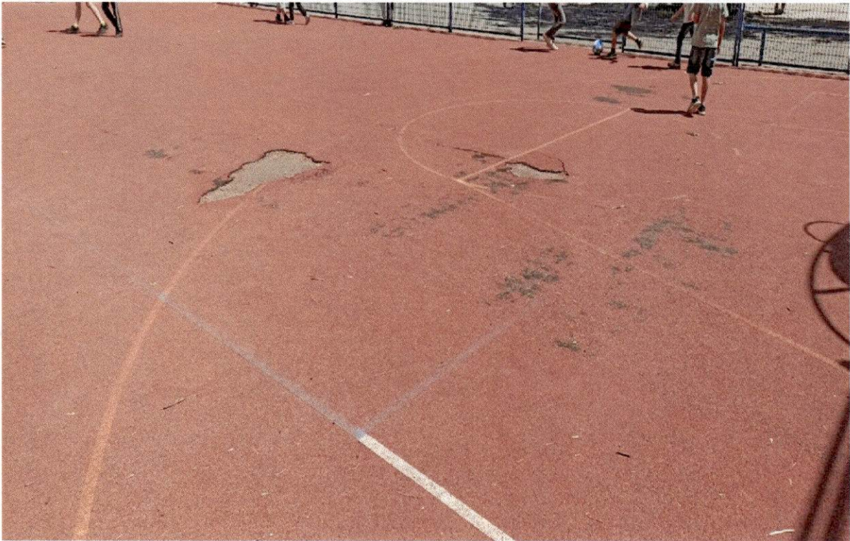
Abbildung 7 Spielfeld mit löchrigem Kunststoffbodenbelag
