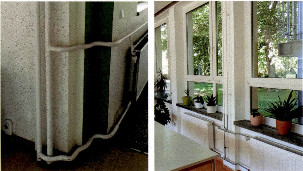
Abbildung 15 Ungedämmte Heizungsleitungen
