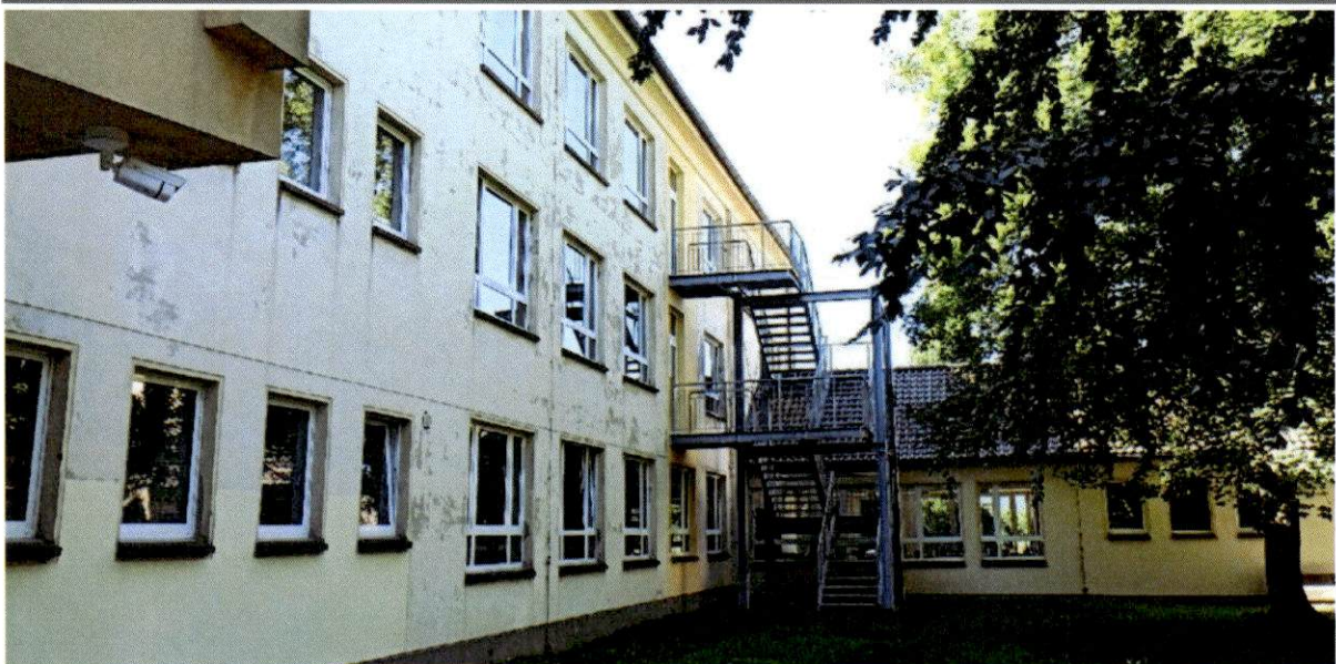
Abbildung 66 Fluchttreppenhaus an denkmalgeschütztem Gebäude
