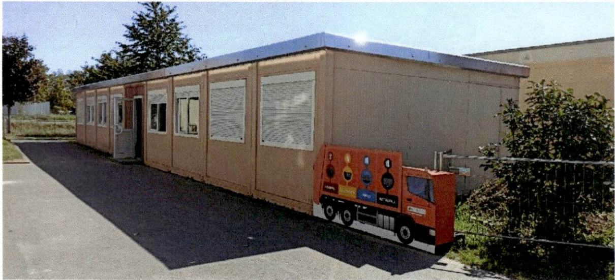
Abbildung 63 Erweiterung mittels Containerlösung (2 Klassenzimmer mit Nebenraum)
