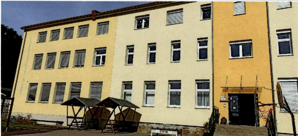
Abbildung 36 Energetisch sanierte Fassade mit Sonnenschutz (2012)
