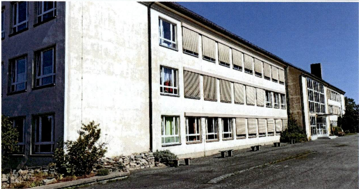
Abbildung 9 Ungedämmte Gebäudehülle
