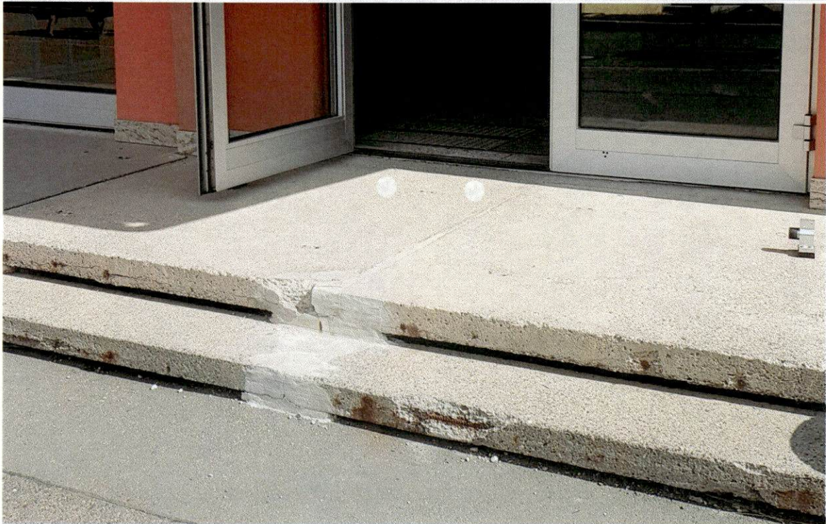
Abbildung 6 Kaputte Eingangsstufen
