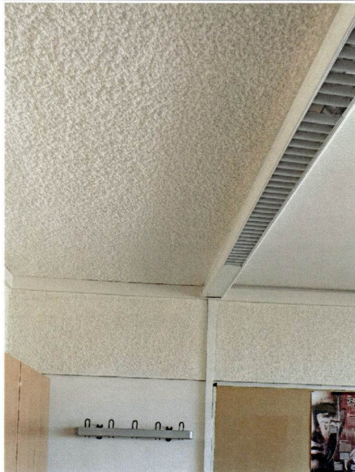
Abbildung 64 Schallschutztechnische Ertüchtigung mit Spritzputz
