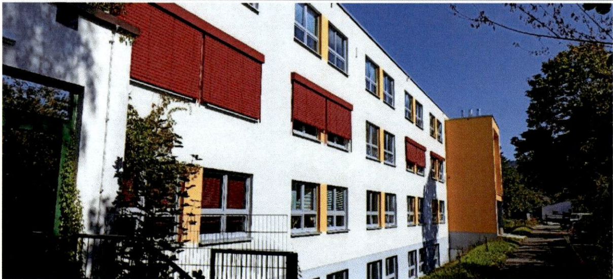
Abbildung 10 Fassade Südseite mit partiellem Sonnenschutz
