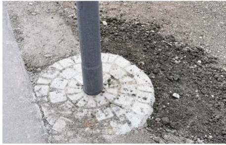
Abb. 20 Beispiel Mastumpflasterung in unbefestigten Flächen
