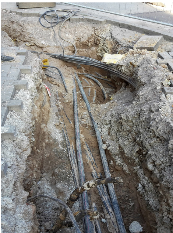
Abbildung 8: Beispiel für Leitungslage im unterirdischen Bauraum
