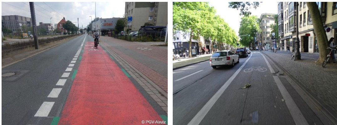
Abb. 6-2: Beispiele für Radfahrstreifen im Zuge von Fahrstreifenreduzierungen (Hildesheimer Straße, Hannover (links) und Habsburger Ring, Köln (rechts))
