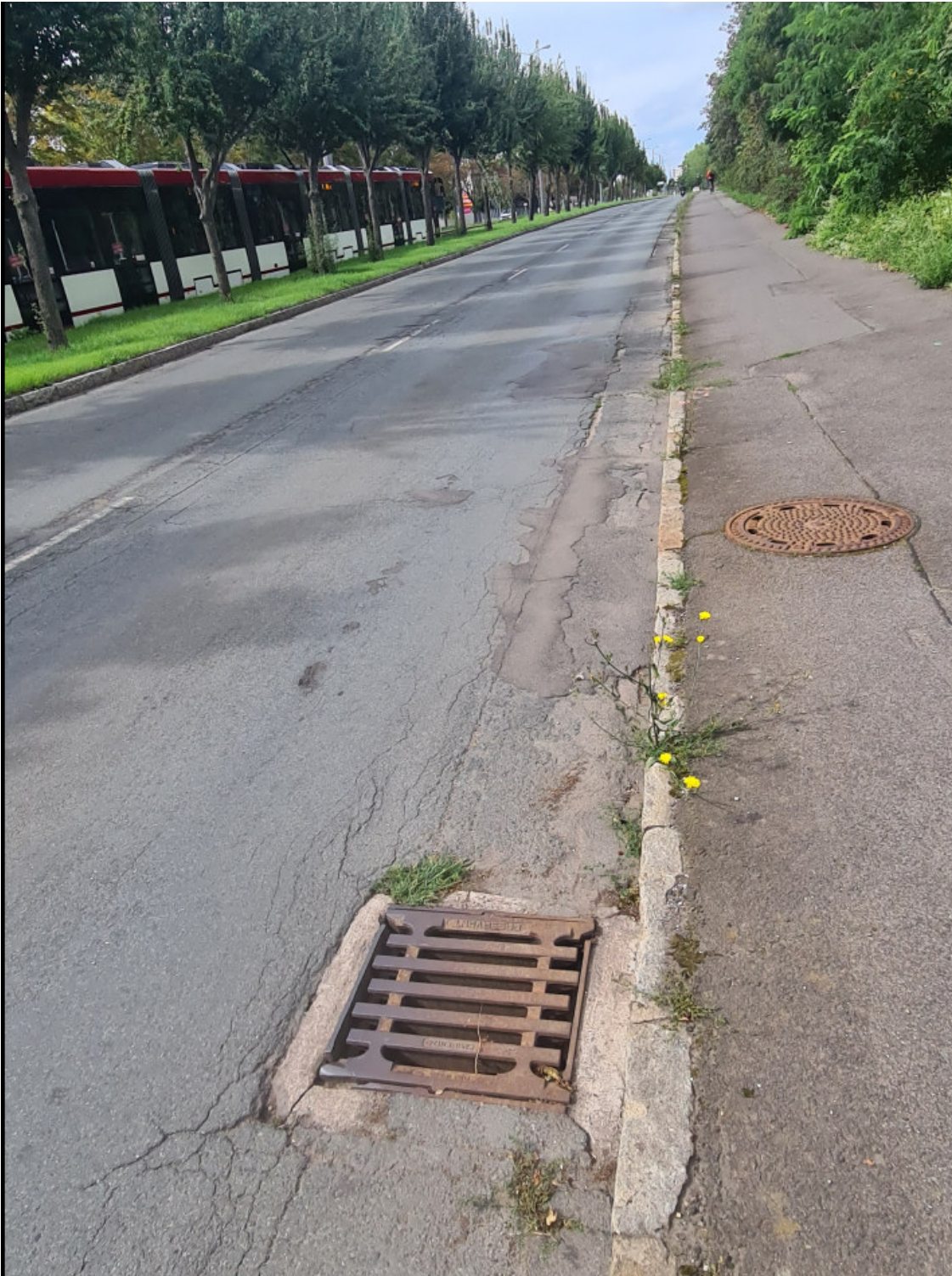
Bauabschnitt 2 Nordhäuser Straße (Warschauer Straße bis Marie-E.-Kayser-Straße)
