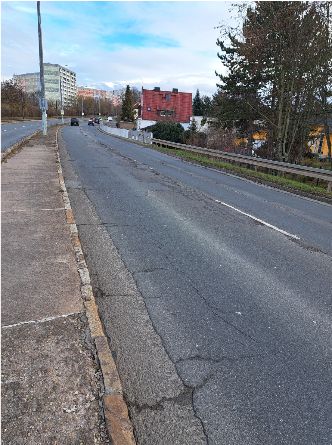
Bauabschnitt 1 Nordhäuser Straße (Moskauer Straße bis Warschauer Straße)
