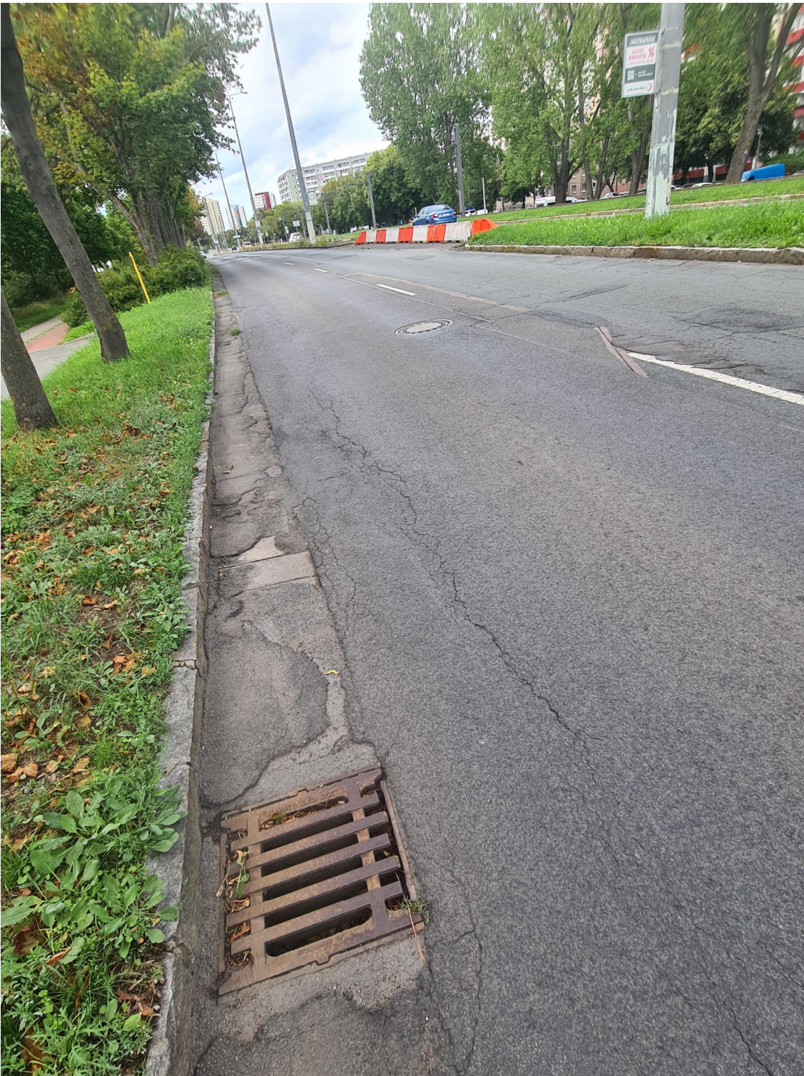
Bauabschnitt 2 Nordhäuser Straße (Warschauer Straße bis Marie-E.-Kayser-Straße)
