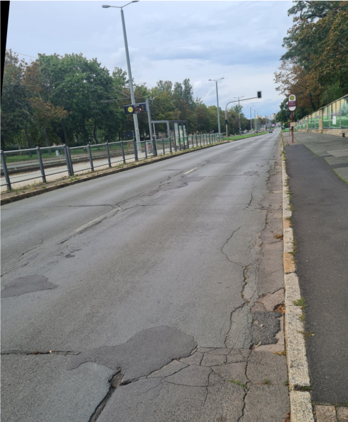
Bauabschnitt 3 Nordhäuser Straße (Marie-E.-Kayser-Straße bis Erhard-Etzlaub-Straße)
