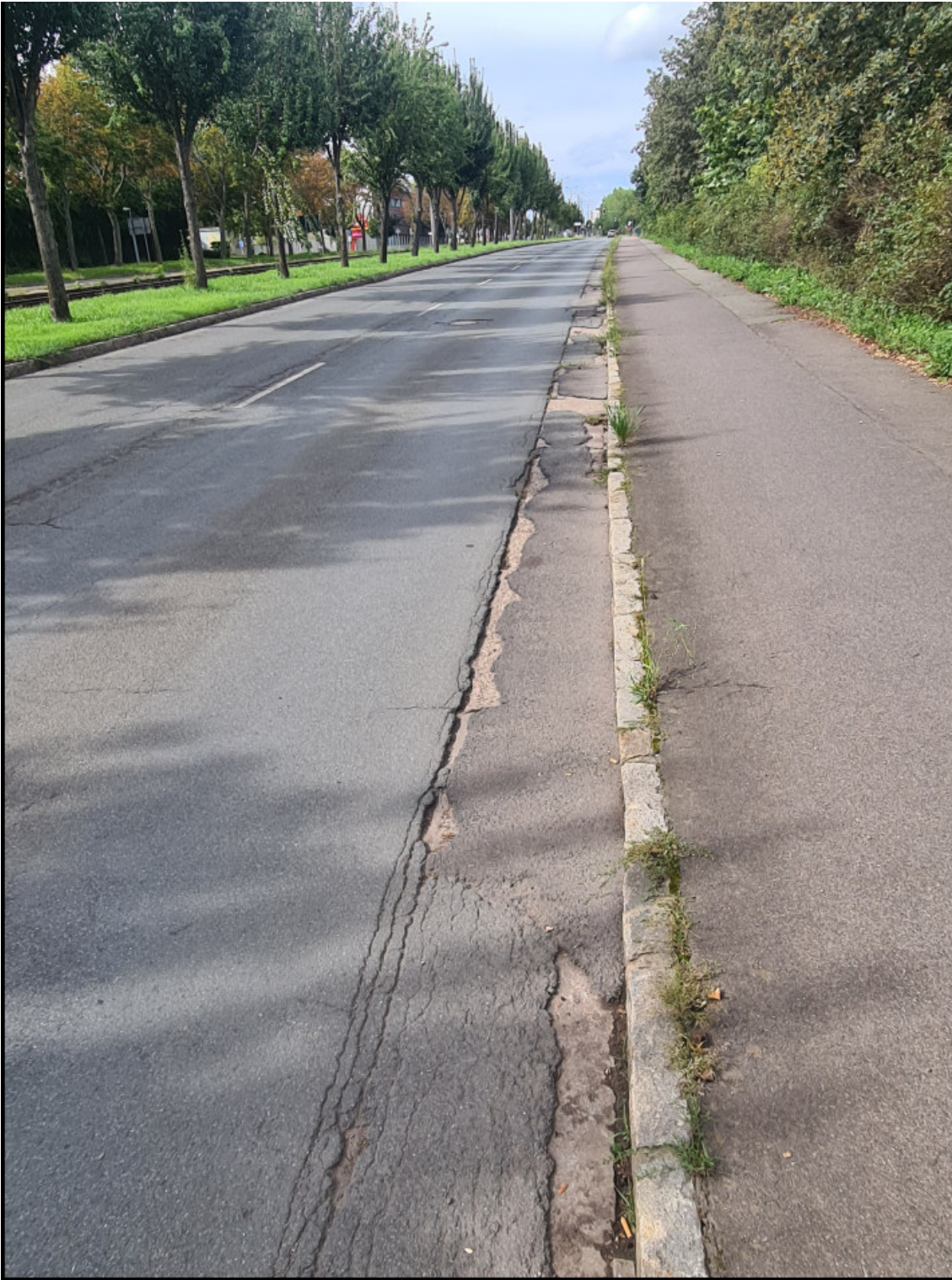
Bauabschnitt 2 Nordhäuser Straße (Warschauer Straße bis Marie-E.-Kayser-Straße)
