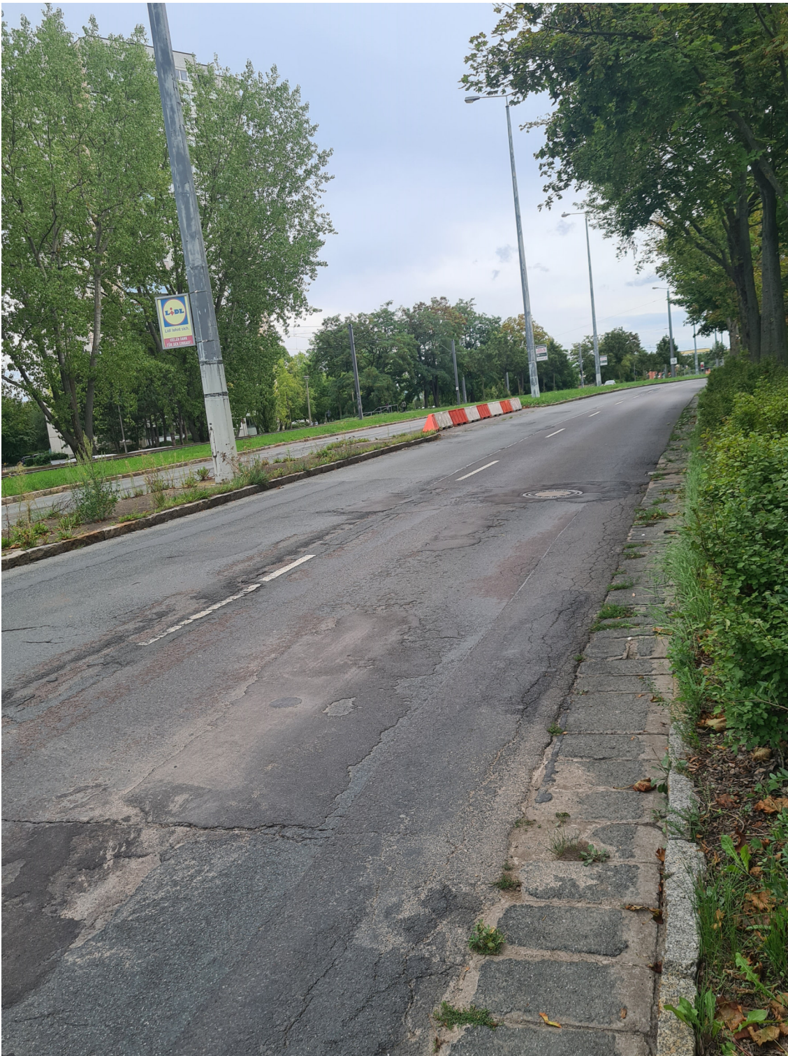
Bauabschnitt 2 Nordhäuser Straße (Warschauer Straße bis Marie-E.-Kayser-Straße)
