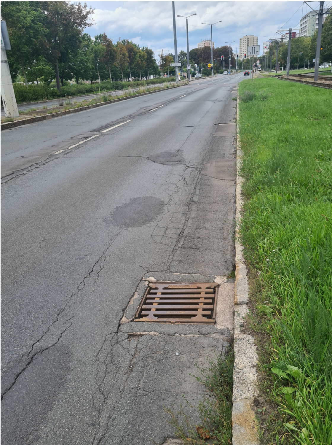
Bauabschnitt 2 Nordhäuser Straße (Warschauer Straße bis Marie-E.-Kayser-Straße)
