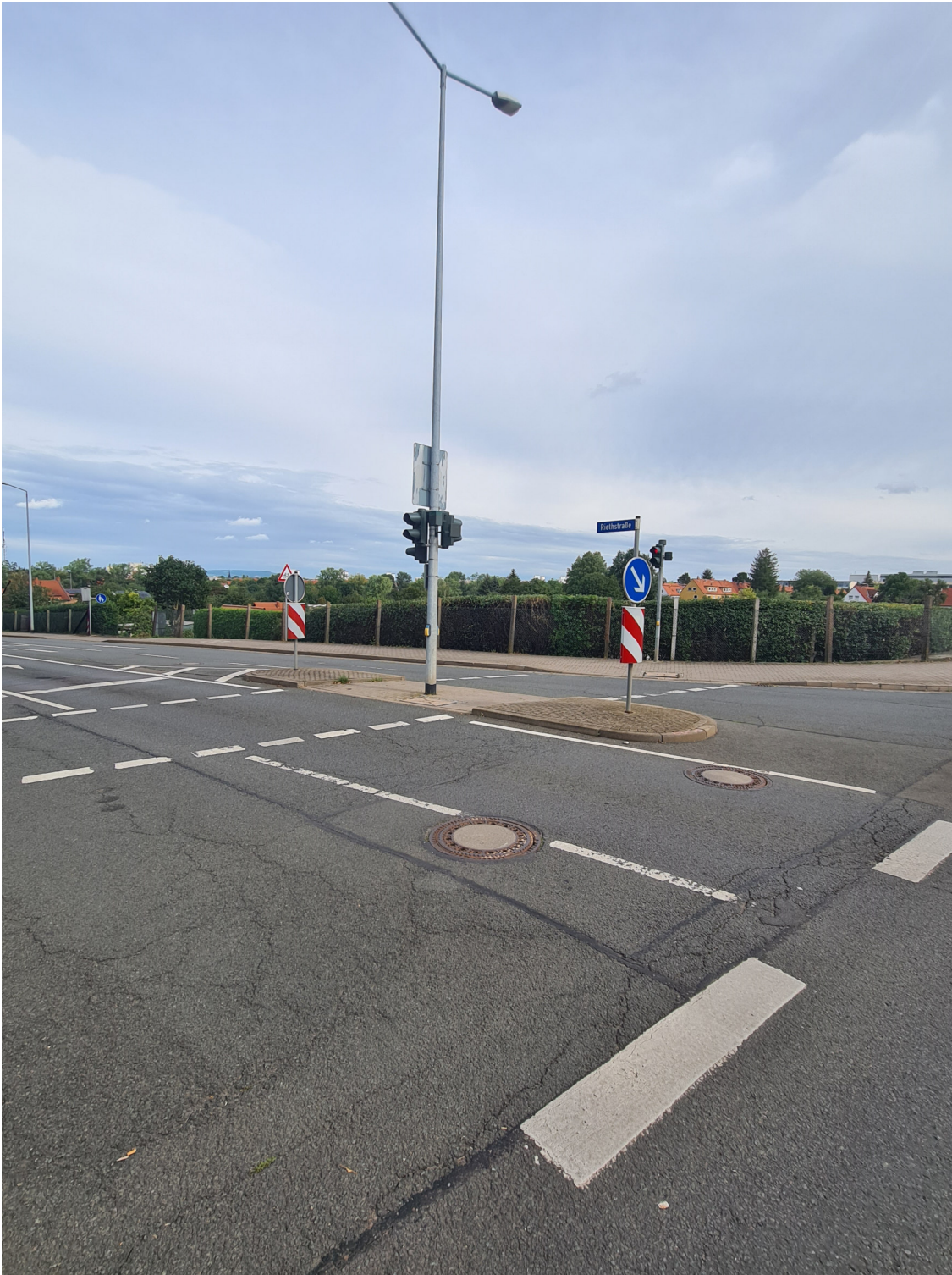
Bauabschnitt 2 Nordhäuser Straße (Warschauer Straße bis Marie-E.-Kayser-Straße)
