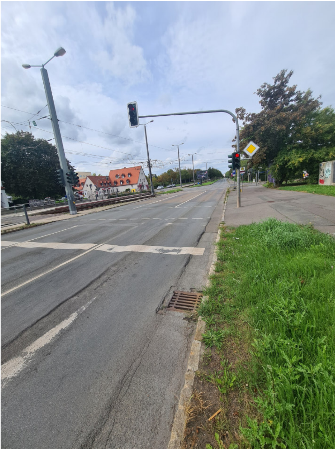
Bauabschnitt 3 Nordhäuser Straße (Marie-E.-Kayser-Straße bis Erhard-Etzlaub-Straße)
