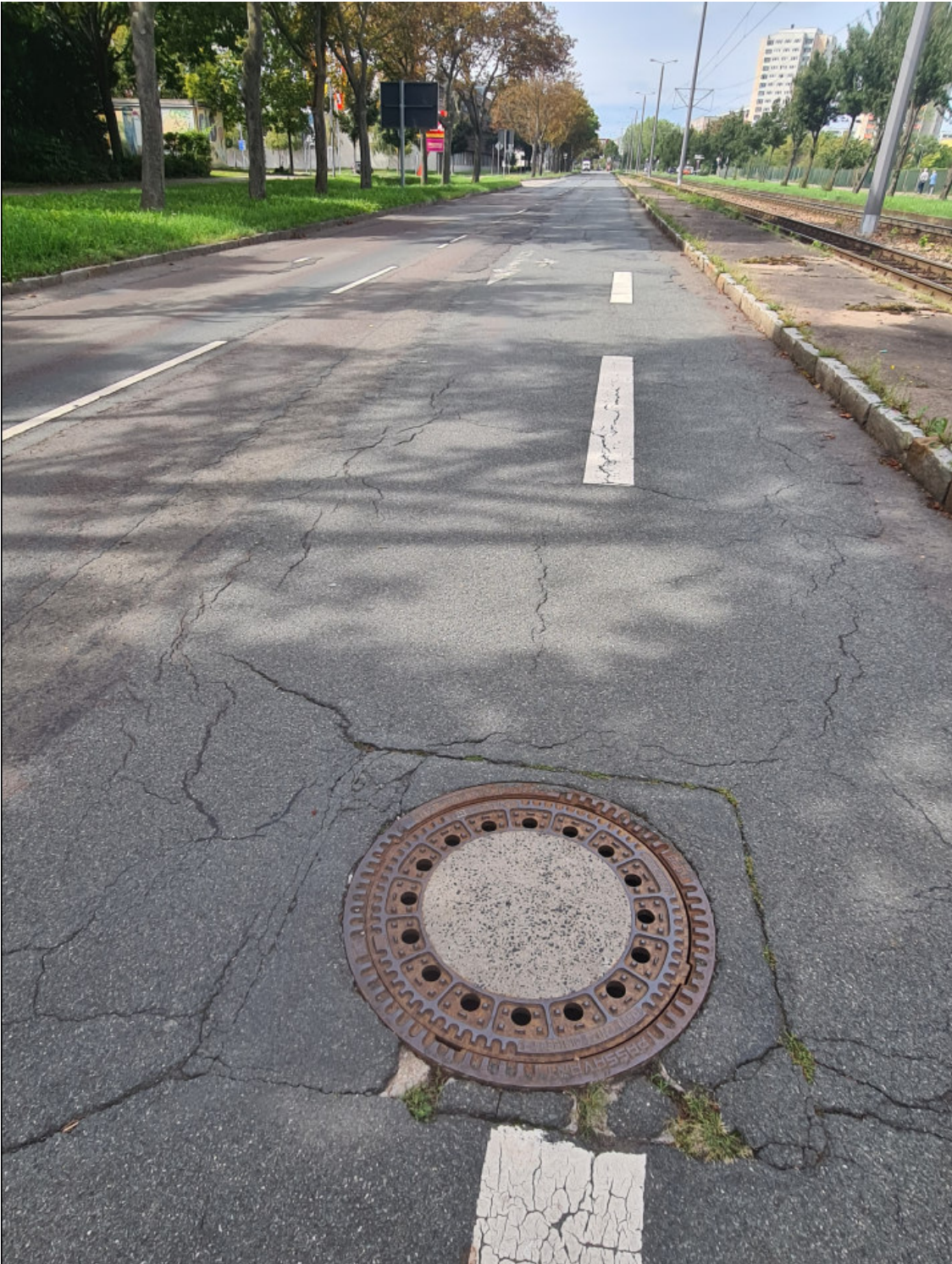
Bauabschnitt 2 Nordhäuser Straße (Warschauer Straße bis Marie-E.-Kayser-Straße)
