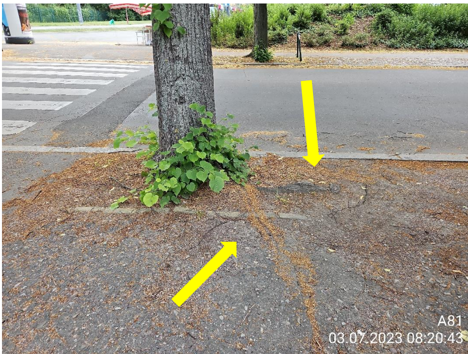
Foto 4 Baum A81 oberflächennaher Wurzelverlauf vermutet
