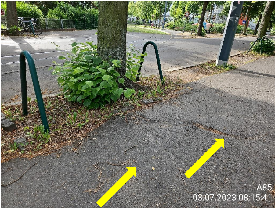
Foto 3 Baum A85 oberflächennaher Wurzelverlauf vermutet
