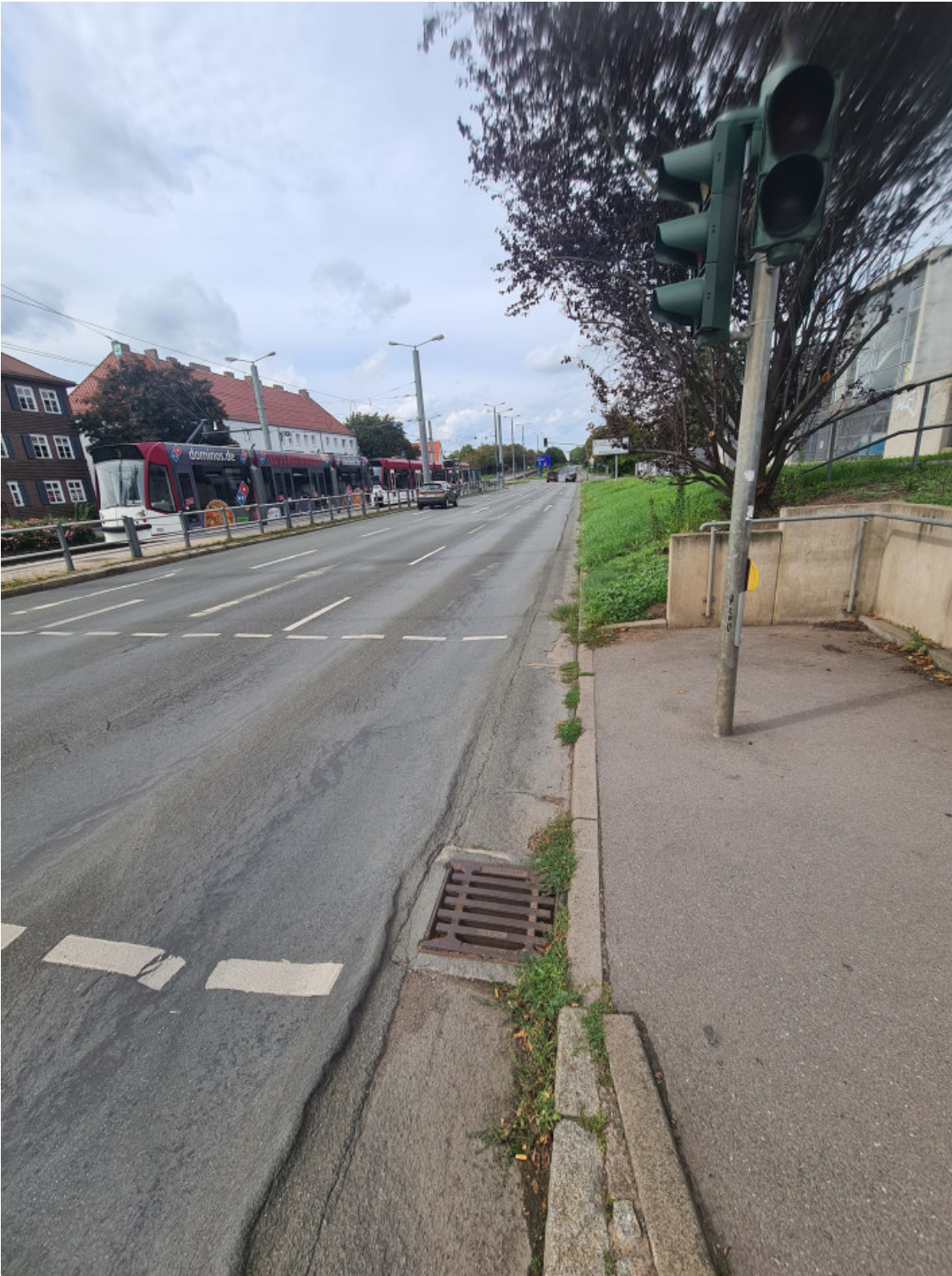
Bauabschnitt 3 Nordhäuser Straße (Marie-E.-Kayser-Straße bis Erhard-Etzlaub-Straße)
