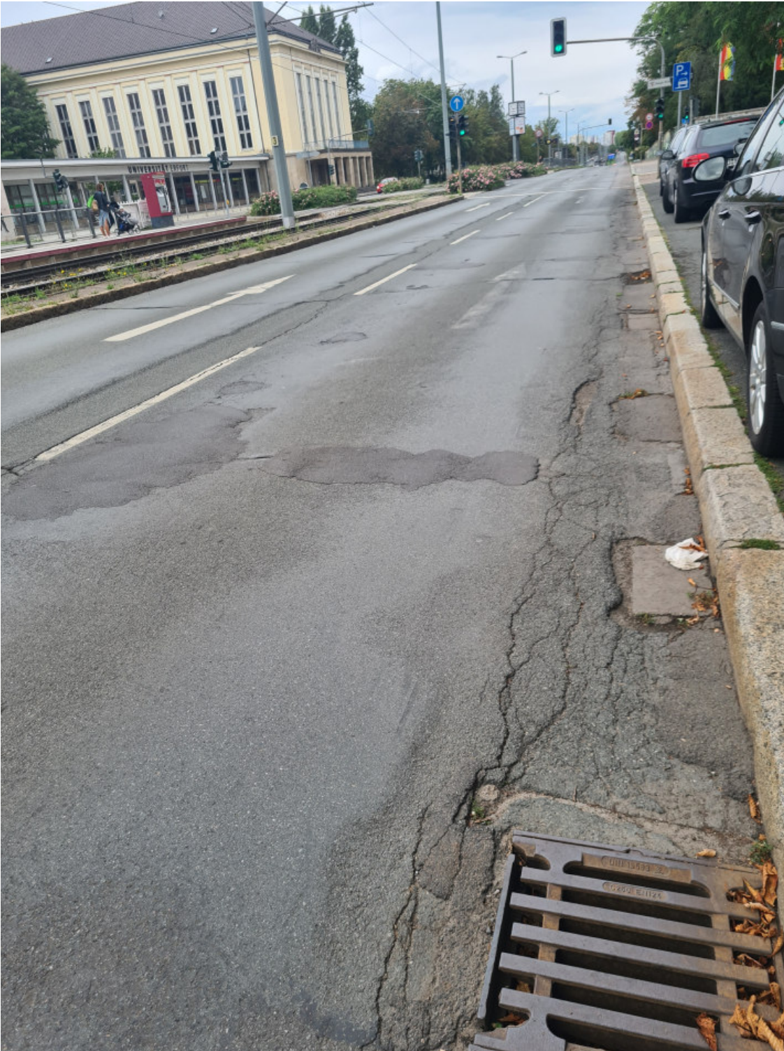
Bauabschnitt 3 Nordhäuser Straße (Marie-E.-Kayser-Straße bis Erhard-Etzlaub-Straße)
