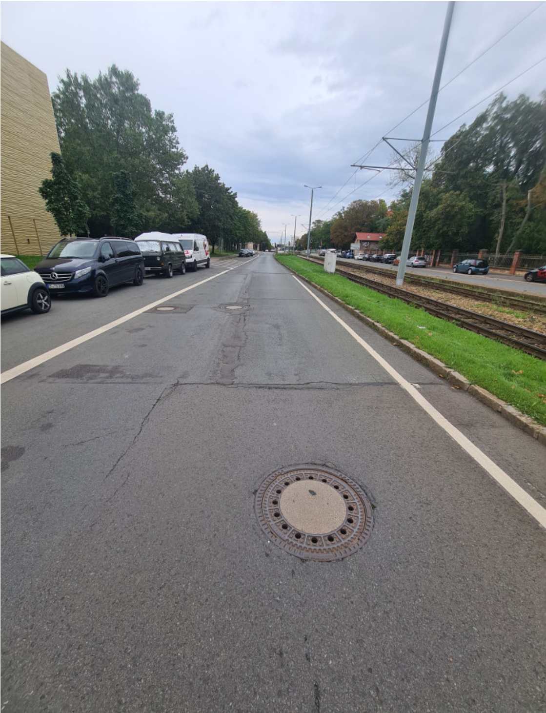
Bauabschnitt 3 Nordhäuser Straße (Marie-E.-Kayser-Straße bis Erhard-Etzlaub-Straße)
