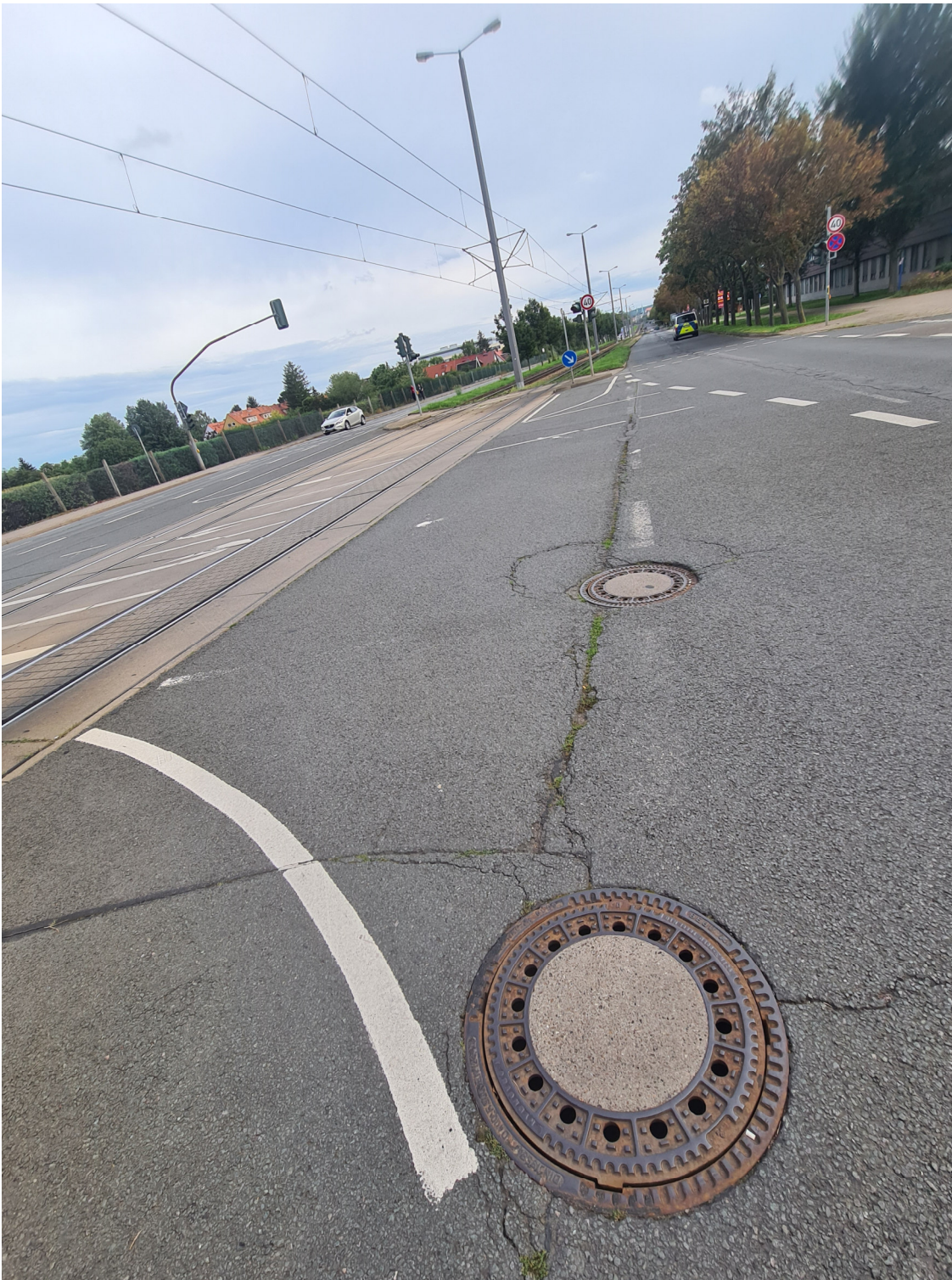
Bauabschnitt 2 Nordhäuser Straße (Warschauer Straße bis Marie-E.-Kayser-Straße)
