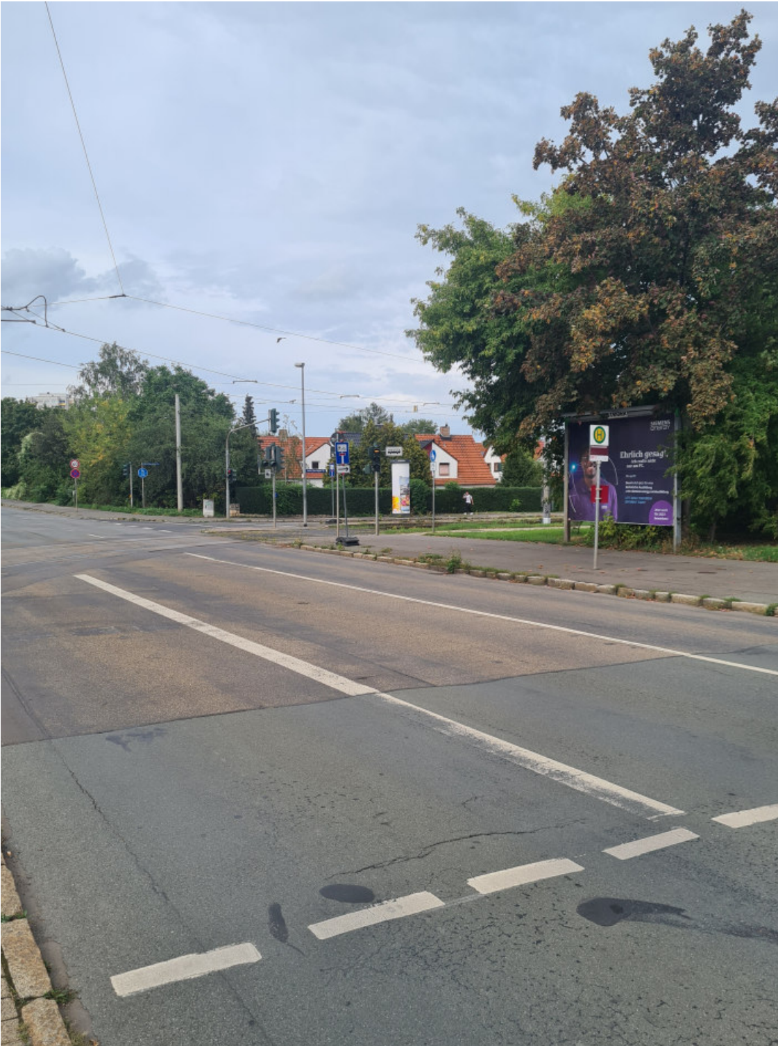
Bauabschnitt 3 Nordhäuser Straße (Marie-E.-Kayser-Straße bis Erhard-Etzlaub-Straße)
