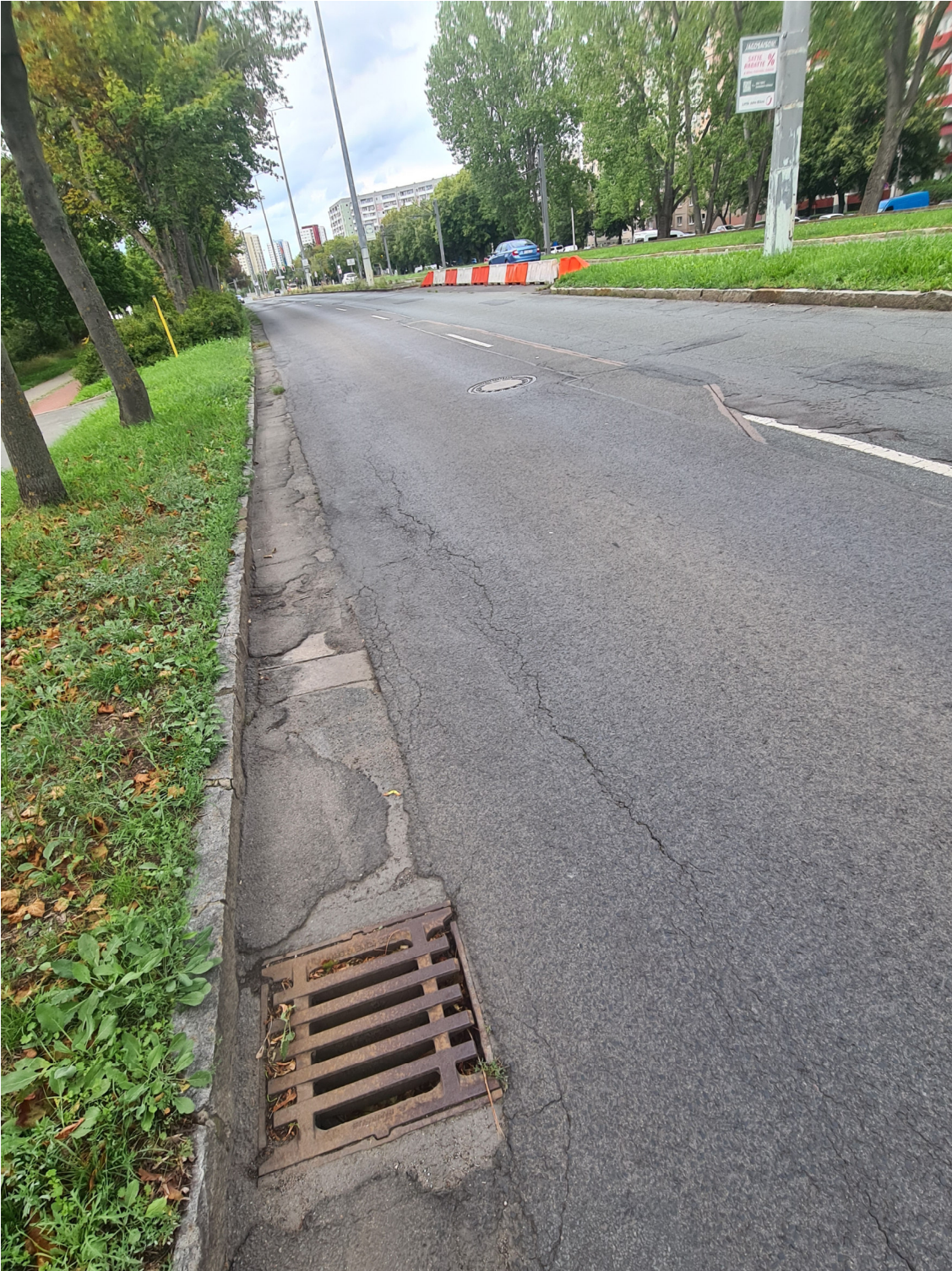
Bauabschnitt 2 Nordhäuser Straße (Warschauer Straße bis Marie-E.-Kayser-Straße)
