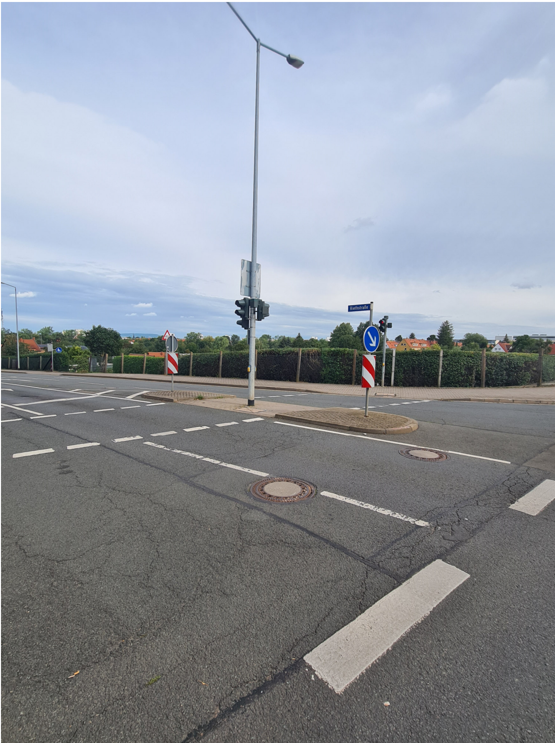
Bauabschnitt 2 Nordhäuser Straße (Warschauer Straße bis Marie-E.-Kayser-Straße)
