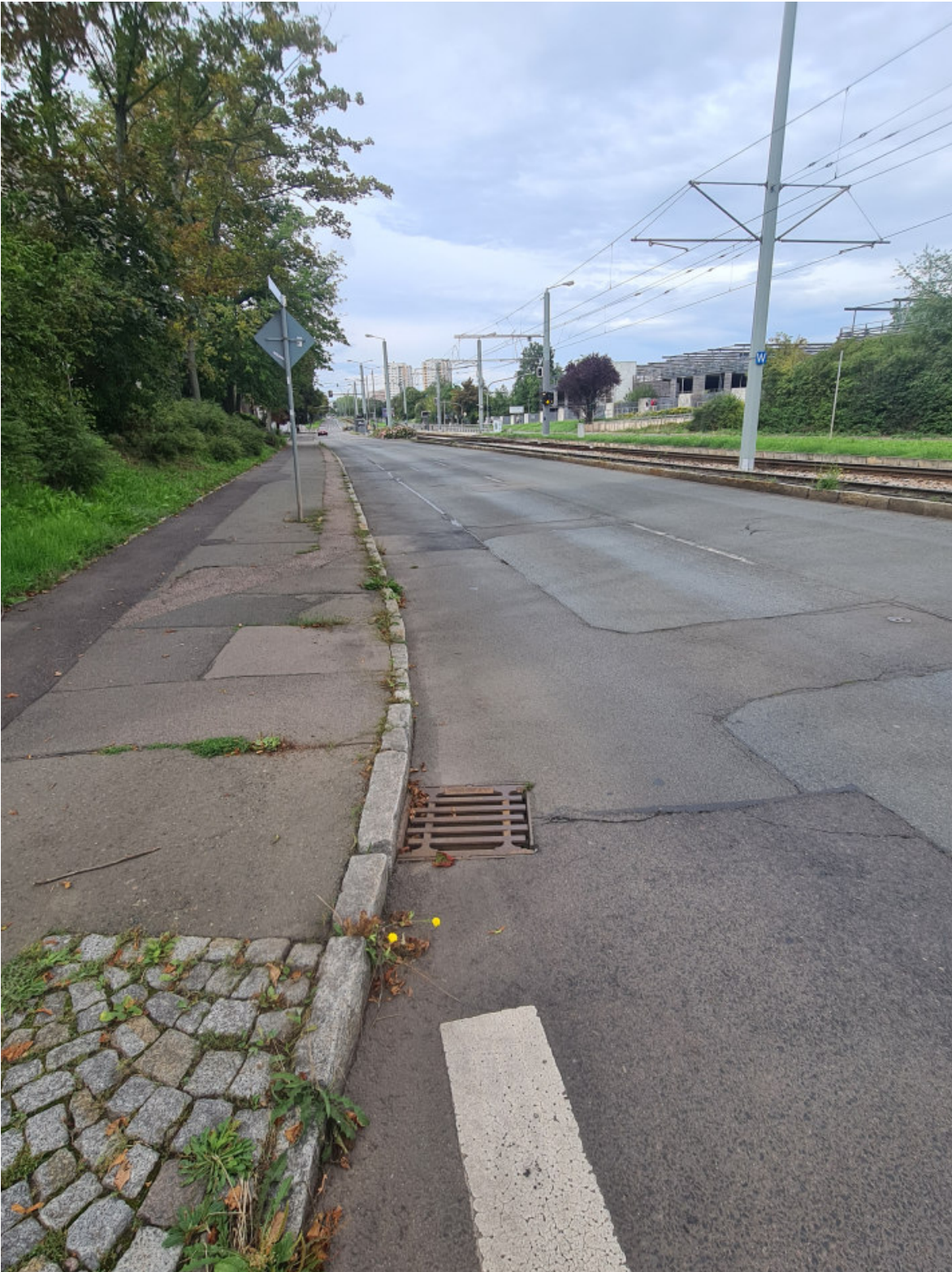
Bauabschnitt 3 Nordhäuser Straße (Marie-E.-Kayser-Straße bis Erhard-Etzlaub-Straße)
