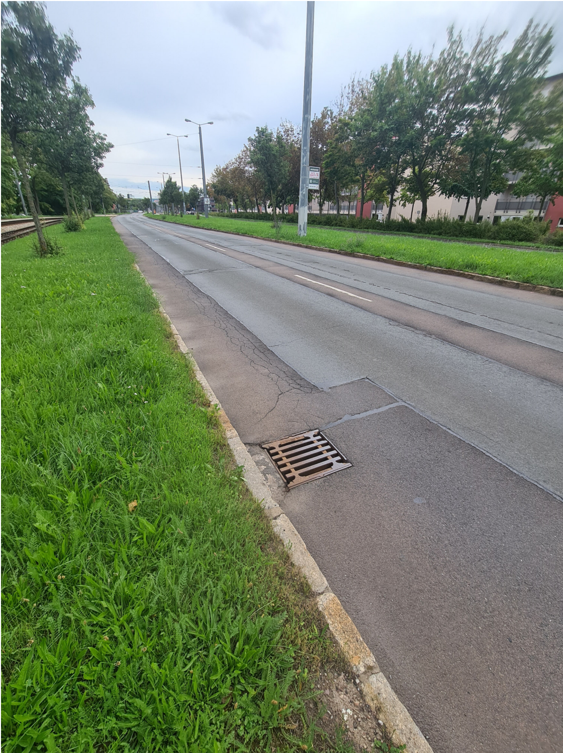
Bauabschnitt 2 Nordhäuser Straße (Warschauer Straße bis Marie-E.-Kayser-Straße)
