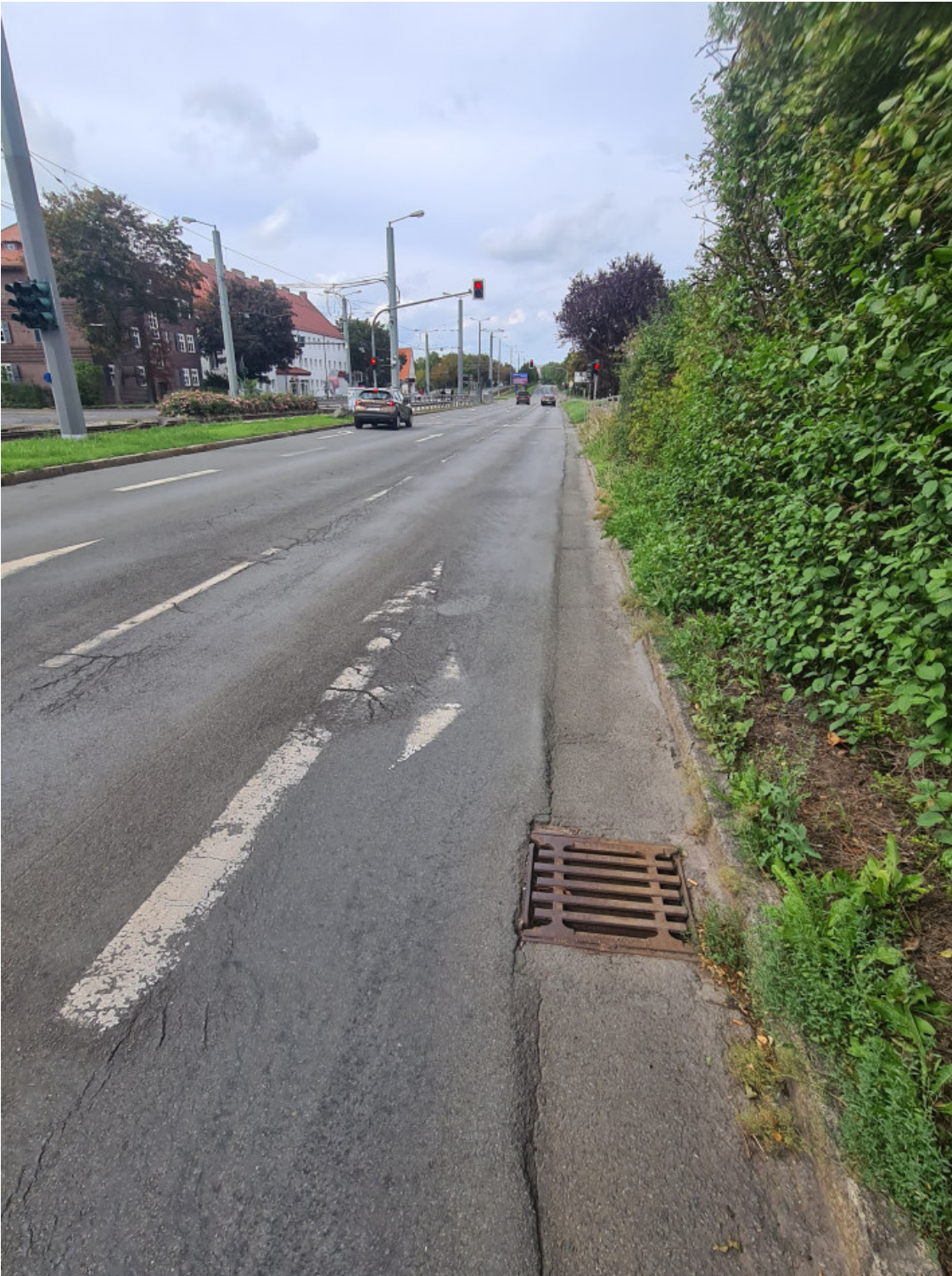
Bauabschnitt 3 Nordhäuser Straße (Marie-E.-Kayser-Straße bis Erhard-Etzlaub-Straße)
