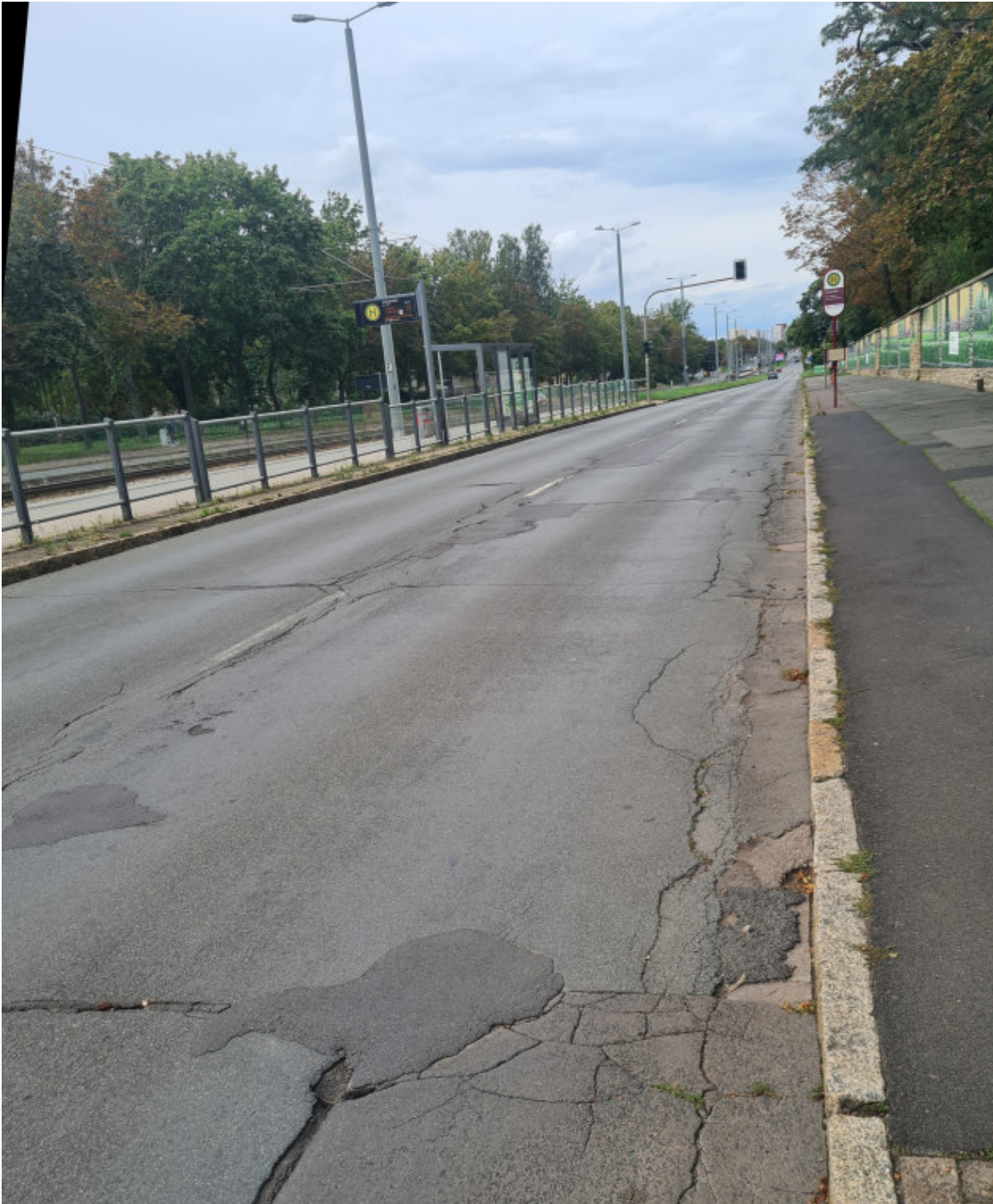
Bauabschnitt 3 Nordhäuser Straße (Marie-E.-Kayser-Straße bis Erhard-Etzlaub-Straße)
