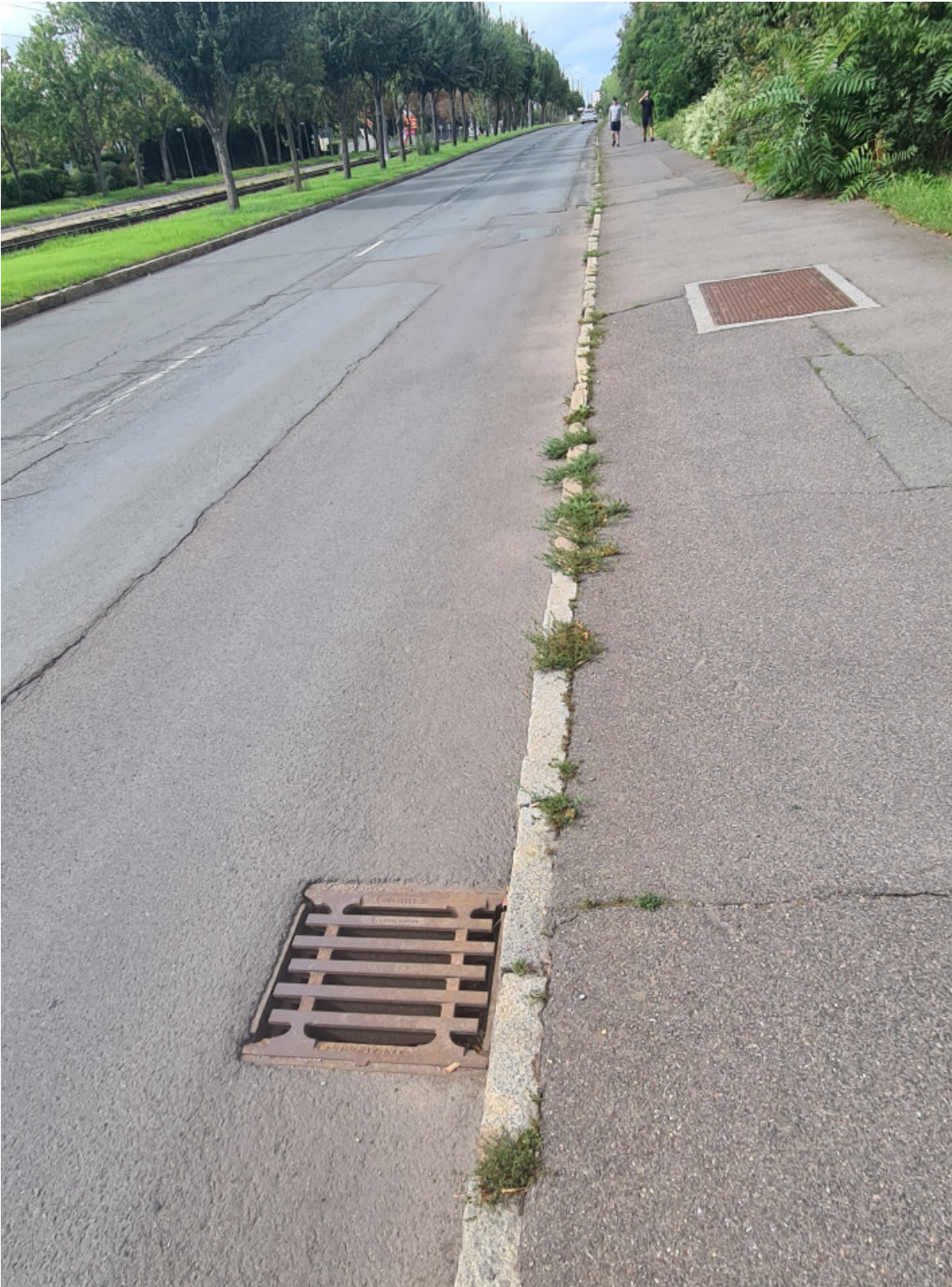
Bauabschnitt 2 Nordhäuser Straße (Warschauer Straße bis Marie-E.-Kayser-Straße)
