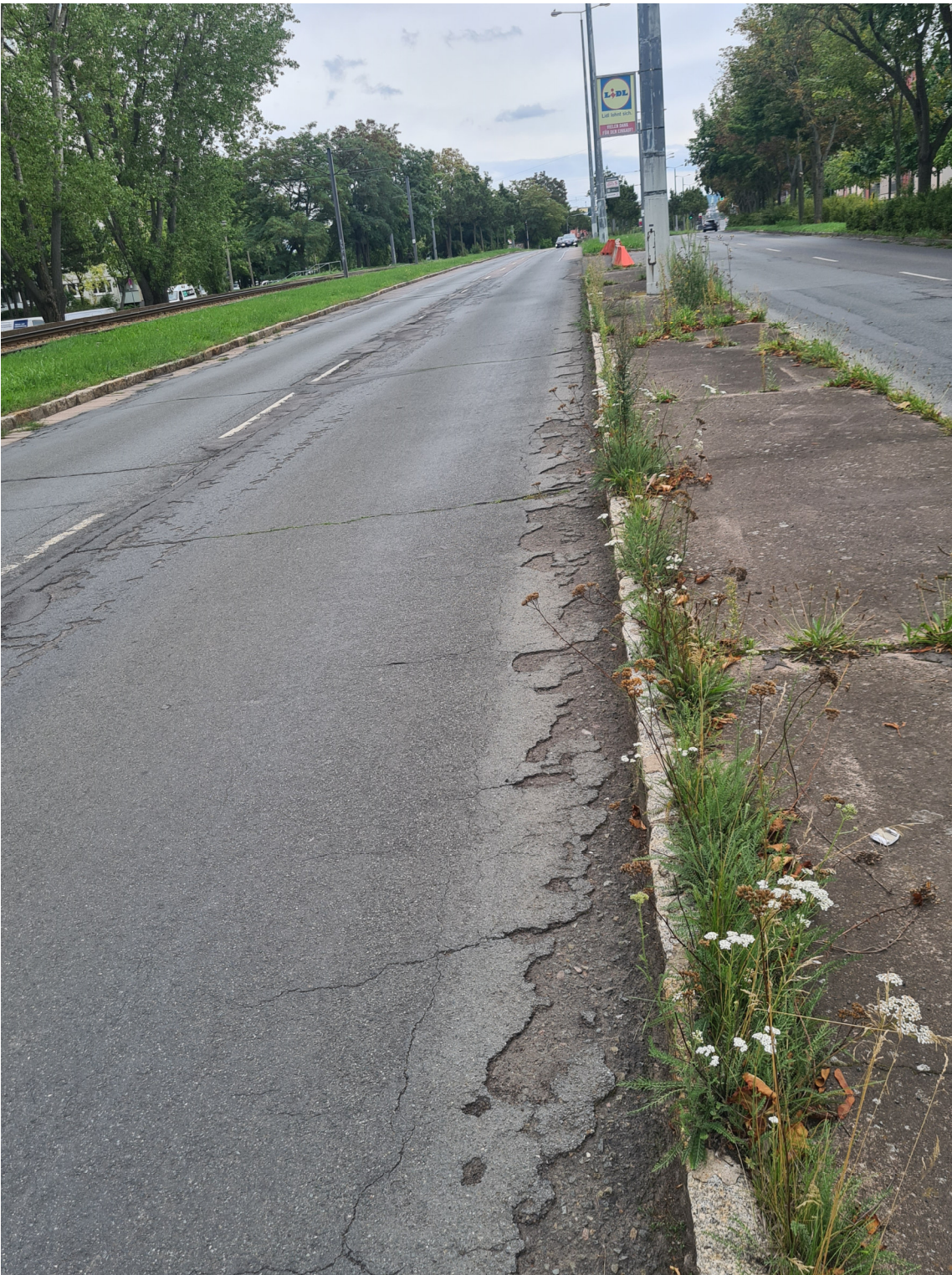
Bauabschnitt 2 Nordhäuser Straße (Warschauer Straße bis Marie-E.-Kayser-Straße)
