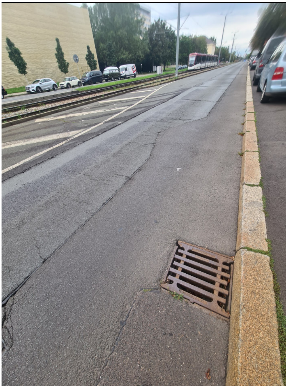
Bauabschnitt 3 Nordhäuser Straße (Marie-E.-Kayser-Straße bis Erhard-Etzlaub-Straße)
