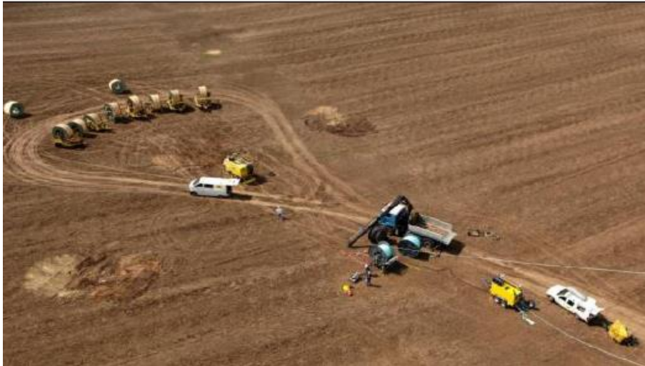
Abbildung 7: Trommel- und Windenplatz für den Seilzug
