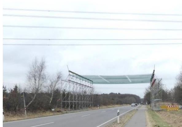
Abbildung 12: Stahlgerüst mit Netzabdeckung
