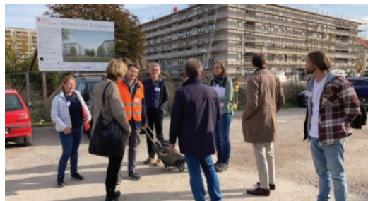
Abbildung 9: Die Teilnehmenden besichtigen die Fläche hinter dem neu entstehenden Bürgerpark.
