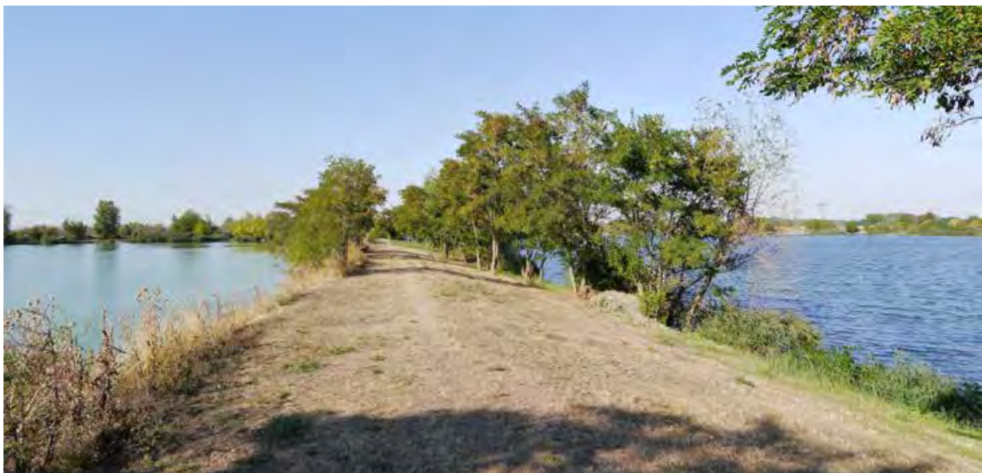
Abb. 39 Dammbereich zwischen Storchensee und Neuem Kiessee II
