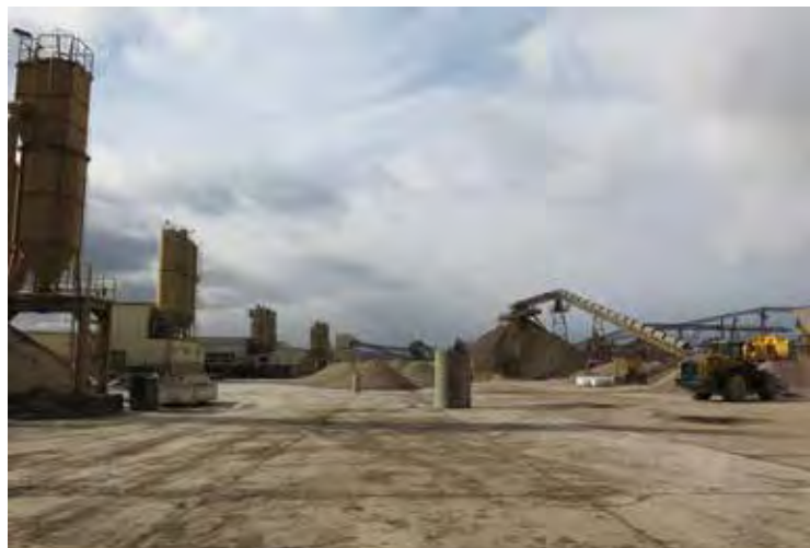
Abb. 71 Aufbereitungsanlage an den Riedseen
