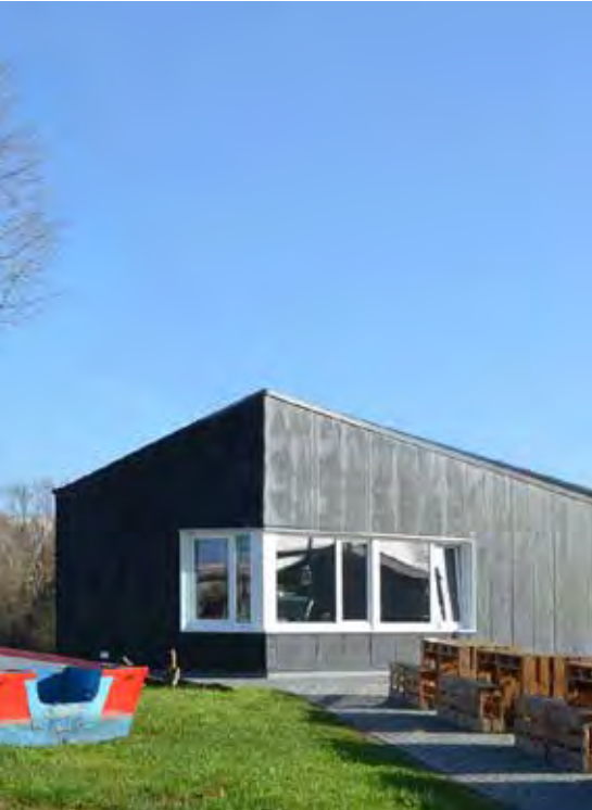
Abb. 134 Referenz Baukultur Vereinsheim am Hafen, Magdeburg, Steinblock Architekten
