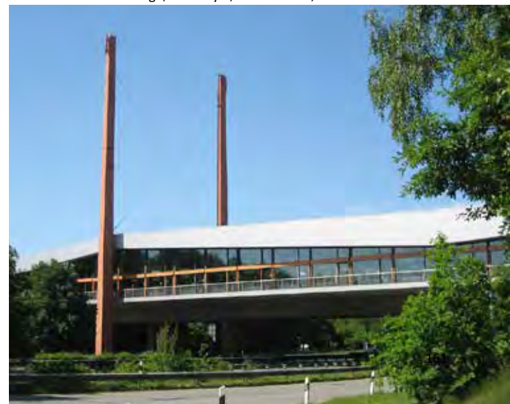
Abb. 146 Beispiel Panoramarestaurant über Straße, Bild: Raststätte Dammer Berge, Mrs. Myer, CC BY-SA 3.0, wikimedia commons
