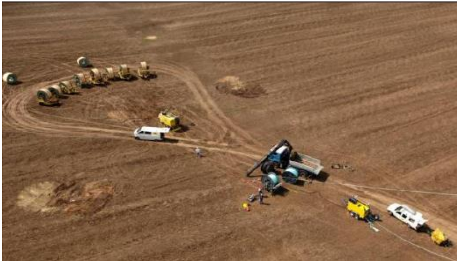
Abbildung 12: Trommel- und Windenplatz (ohne Bodenplatten) für den Seilzug (Quelle: 50Hertz)
