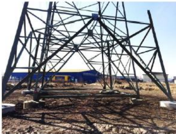
Abbildung 13: Standortgleicher Masttausch: Bestandsmast (innen) umgeben vom neu errichteten Fundament und Mastfuß (außen) (Quelle: 50Hertz)
