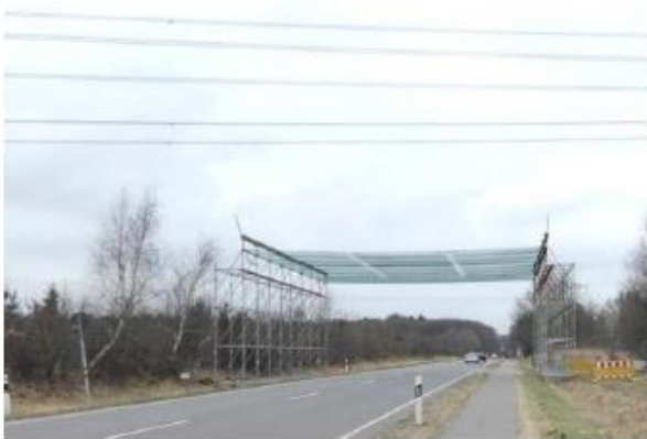
Abbildung 15: Schutzgerüst mit Netzeindeckung (Quelle: 50Hertz)
