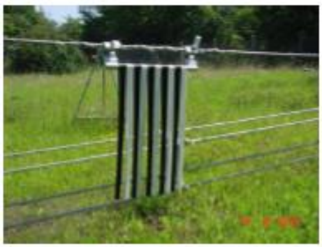
Abbildung 11: Vogelschutzfahne (Klappenmarker) mit einzelnen beweglichen Markierungsglaschen laut RIBE (Quelle: 50Hertz)
