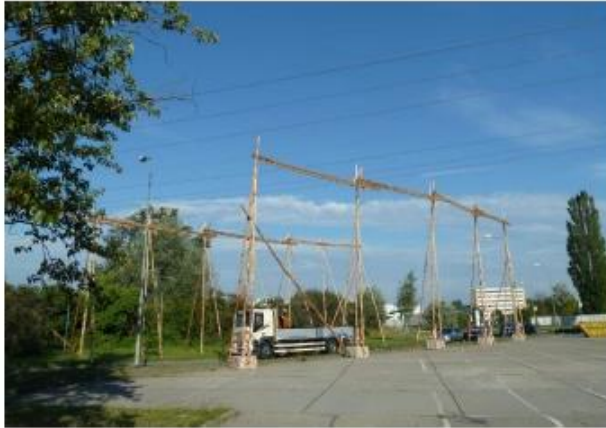
Abbildung 14: Schleifgerüst aus Holz (Quelle: 50Hertz)
