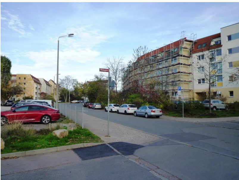
Zufahrt Weidengasse, gegenüberliegende Wohnbebauung Am Hügel
