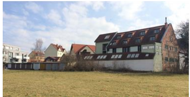
Abb.11: Im Südosten angrenzende Bebauung an der Nikolausstraße
