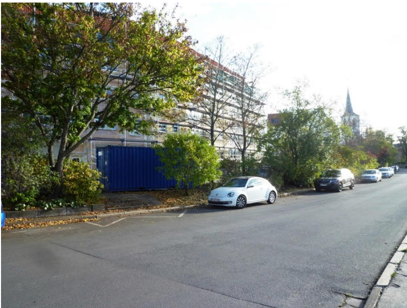
Straße Am Hügel mit Blick auf die Augustinerkirche
