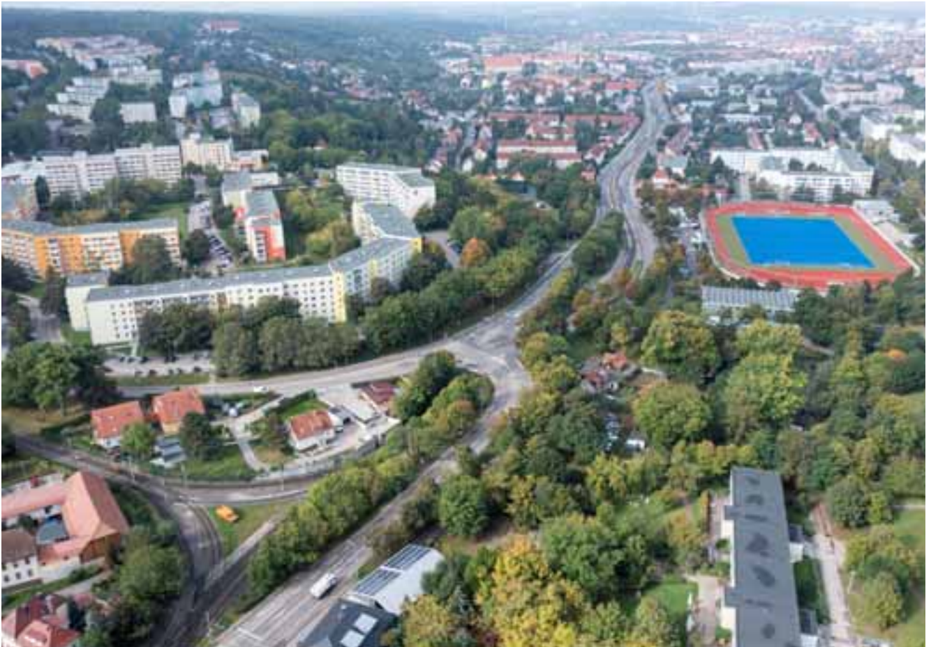
Foto: Schrägluftbild - Blick von Osten auf das Wettbewerbsgebiet
