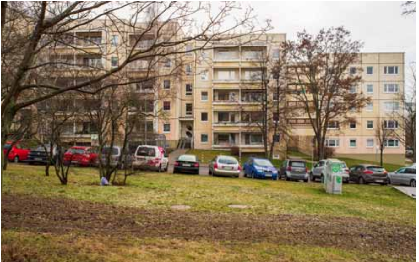
Foto: Blick auf die Bebauung im Bereich Singerstraße
