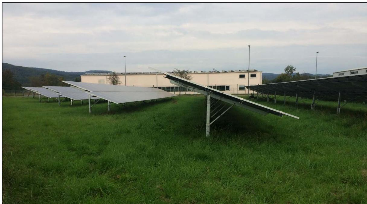
*Abb. 5 und 6: Beispiel für bodenschonend aufgestellte Photovoltaik-Elemente*
