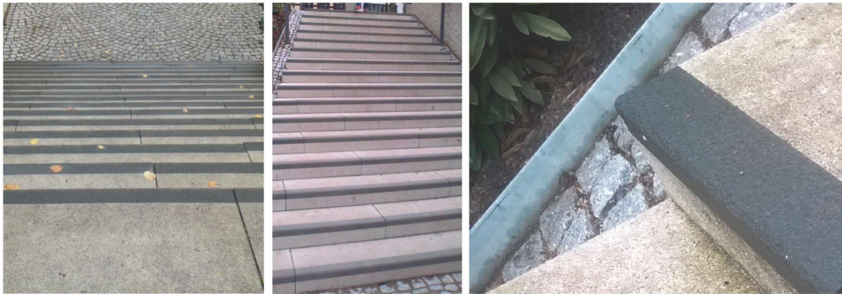
Abbildung 6: Stufenkantenmarkierung an Treppenanlage Mikwe
