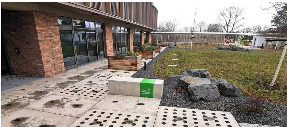
Abb.: Südostfassade mit Hauptzuwegung; Bild: quaas-stadtplaner
