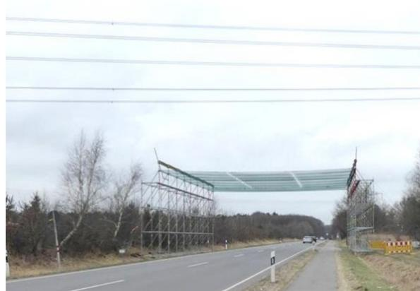
Abbildung 13: Schutzgerüst mit Netzeindeckung
