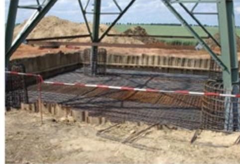
**Abbildung 2: Beispiel eines Plattenfundaments**
