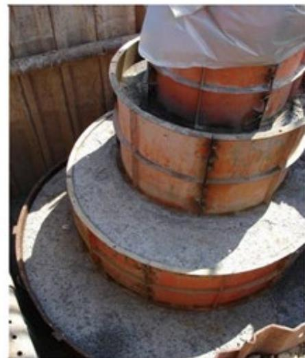
**Abbildung 3: Beispiel eines Stufenfundaments**
