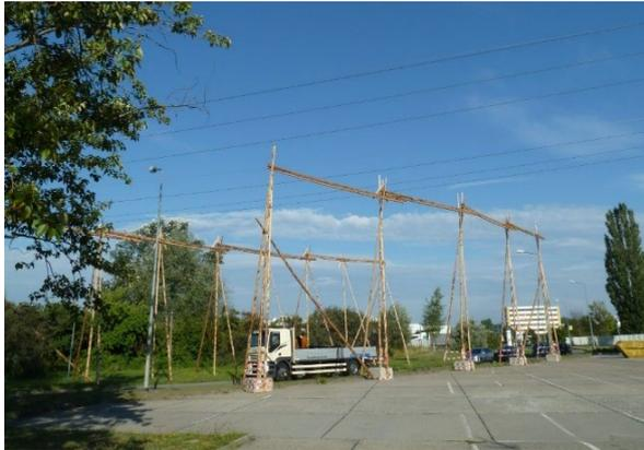
Abbildung 12: Schleifgerüst aus Holz
