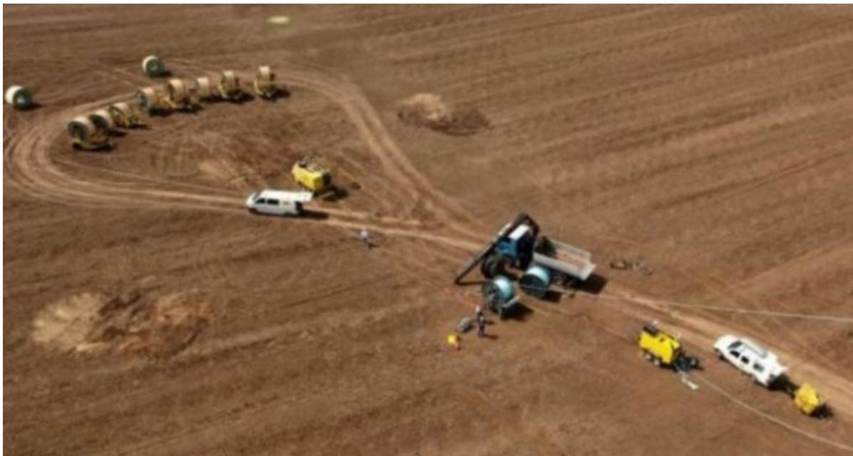
**Abbildung 8: Trommel- und Windenplatz für den Seilzug (Quelle: 50Hertz)**
