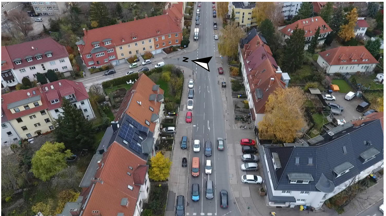
Abb. 5: Drohnenbefliegung – Häblerstrasse, zwischen Clara-Zetkin-Strasse und Wilhelm-Busch-Strasse (Erhebung 2)
