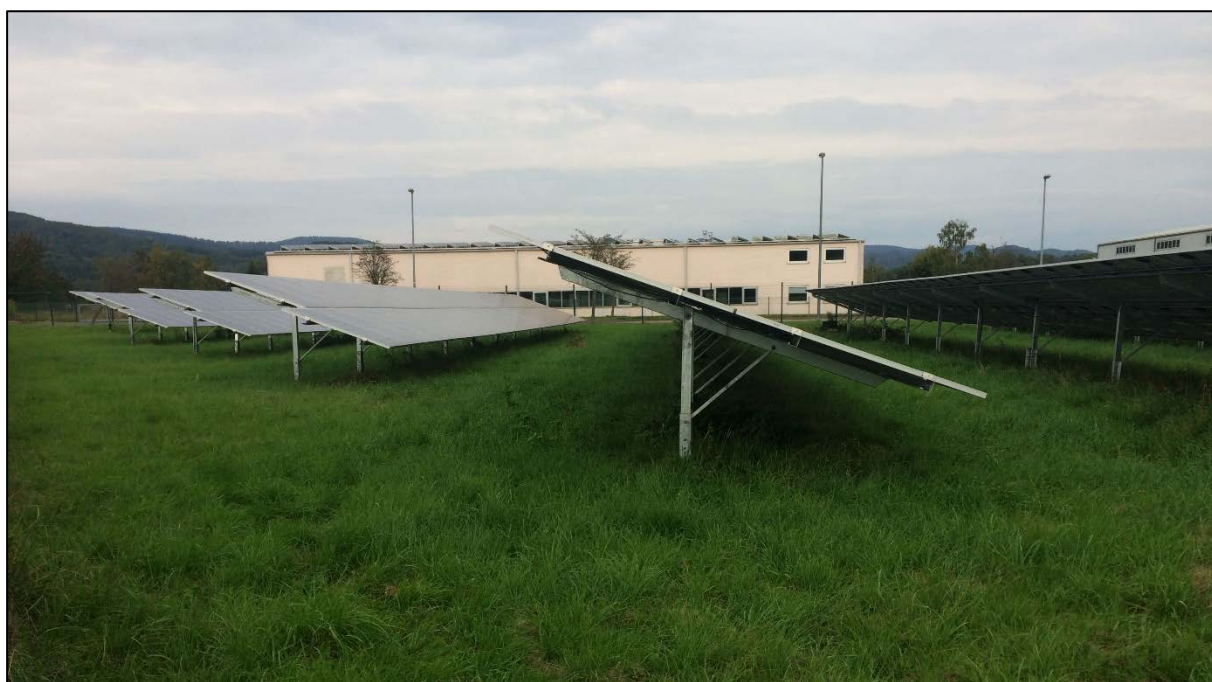
Abb. 5 und 6: Beispiel für bodenschonend aufgestellte Photovoltaik-Elemente
