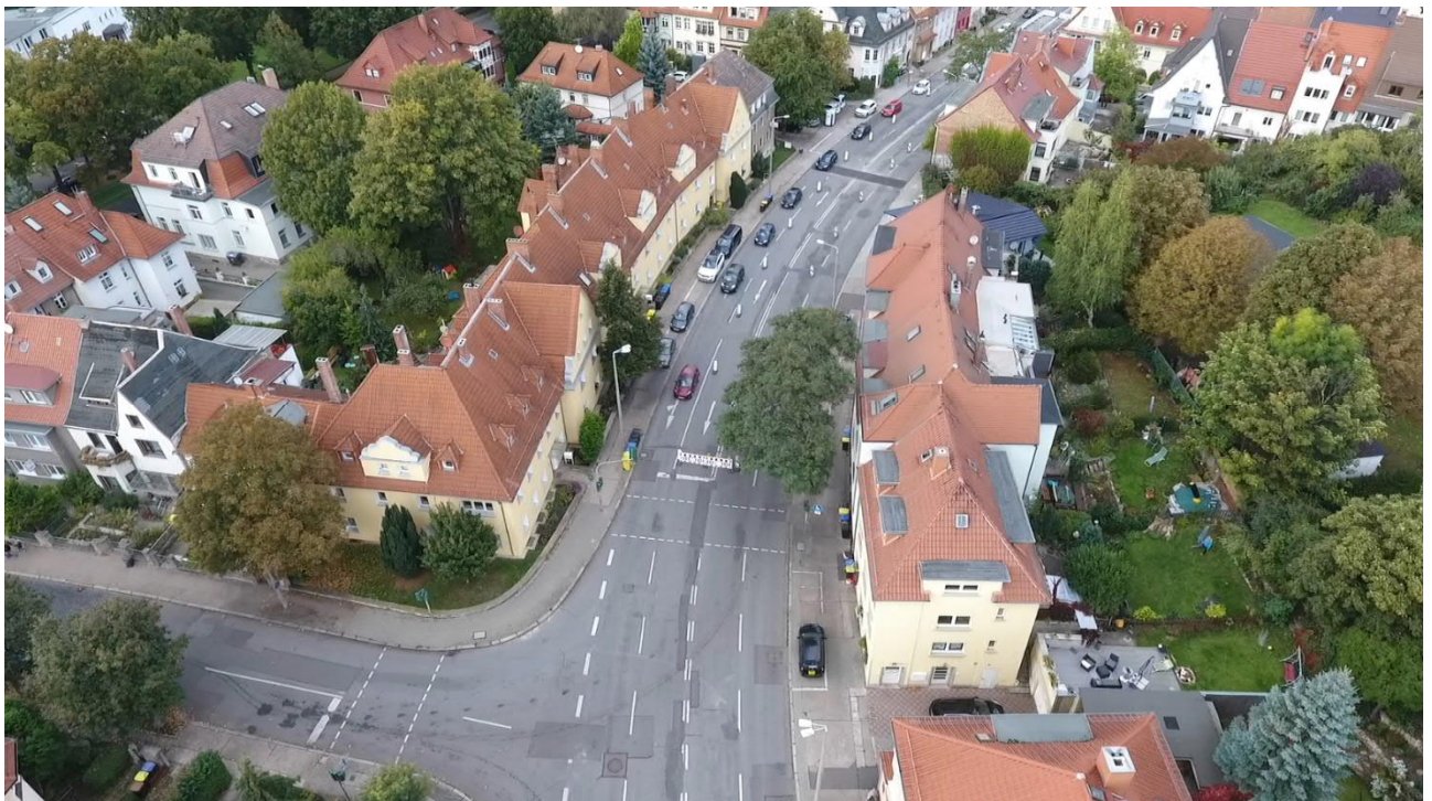
Abb. 9: Drohnenbefliegung – Clara-Zetkin-Straße von Süden nach Norden – Abschnitt 4
