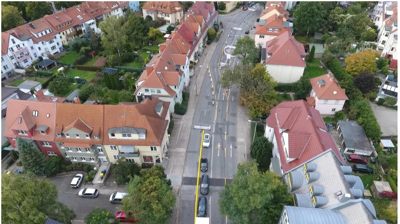
Abb. 8: Drohnenbefliegung – Clara-Zetkin-Straße von Süden nach Norden – Abschnitt 3
