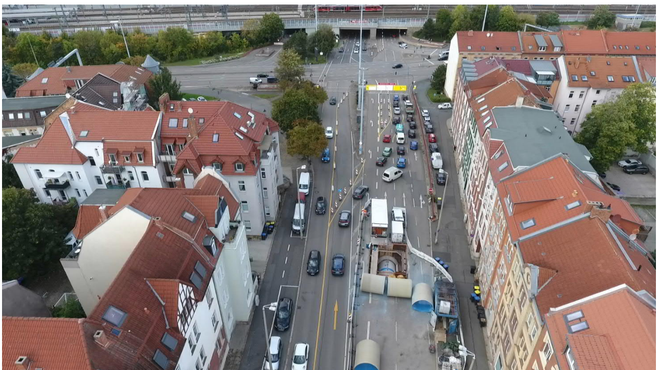
Abb. 15: Drohnenbefliegung – Clara-Zetkin-Straße von Süden nach Norden – Abschnitt 10
