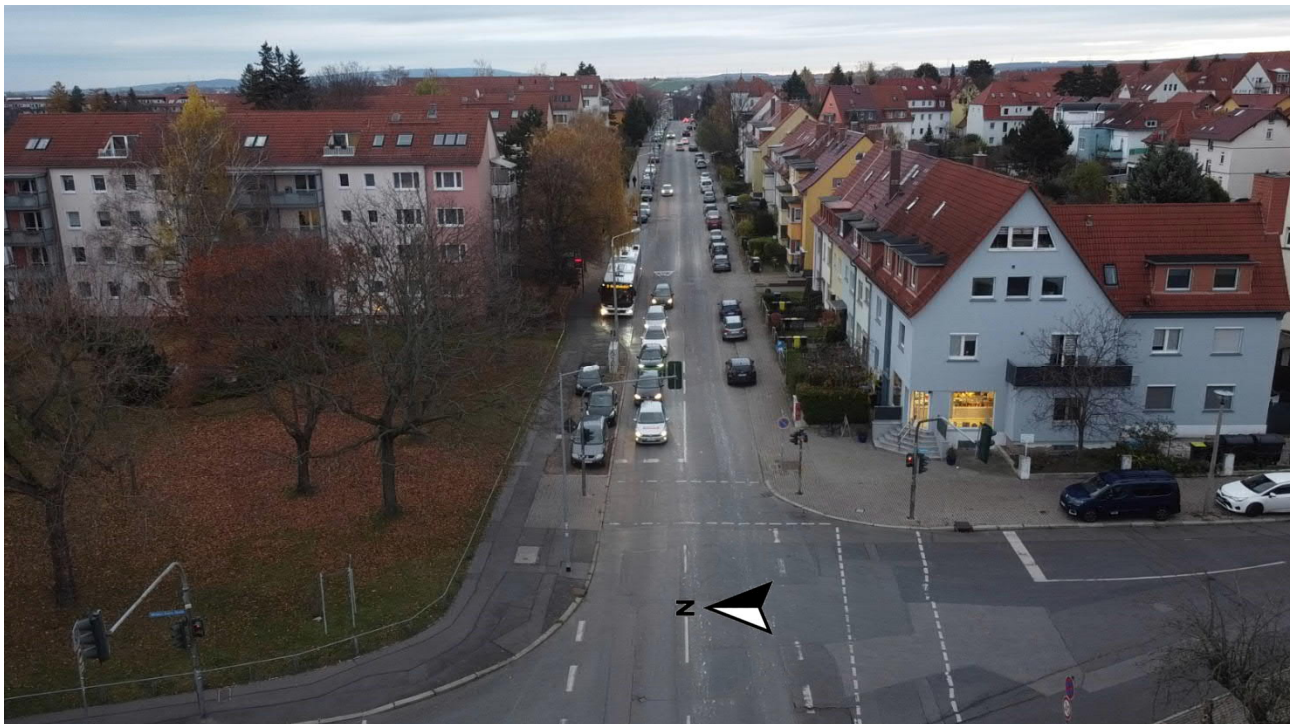
Abb. 3: Drohnenbefliegung – Häblerstraße, östlich Wilhelm-Busch-Straße (Erhebung 2)
