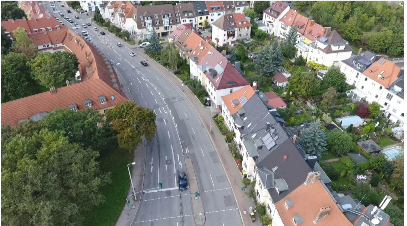
Abb. 6: Drohnenbefliegung – Clara-Zetkin-Straße von Süden nach Norden – Abschnitt 1
