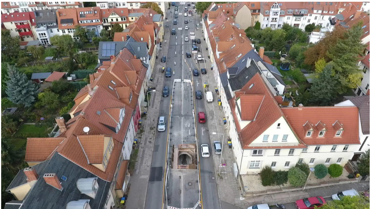
Abb. 11: Drohnenbefliegung – Clara-Zetkin-Straße von Süden nach Norden – Abschnitt 6
