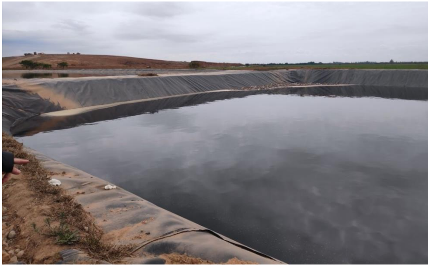
Abbildung 8: Becken mit Sickerwasser auf der Deponie in Tucumán
