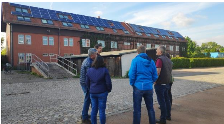
Abbildung 12: Besichtigung der Solaranlage auf dem Erfurter Garten- und Friedhofsamt
