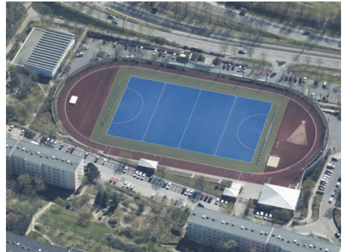
Sportplatzanlage Sportdach Kaufland, Ansicht von Süden
