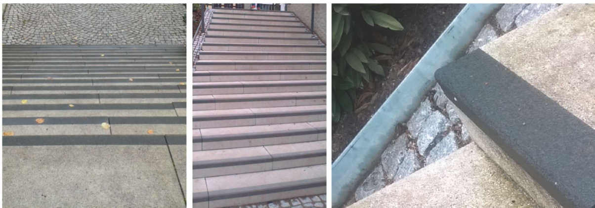
Abbildung 6: Stufenkantenmarkierung an Treppenanlage Mikwe
