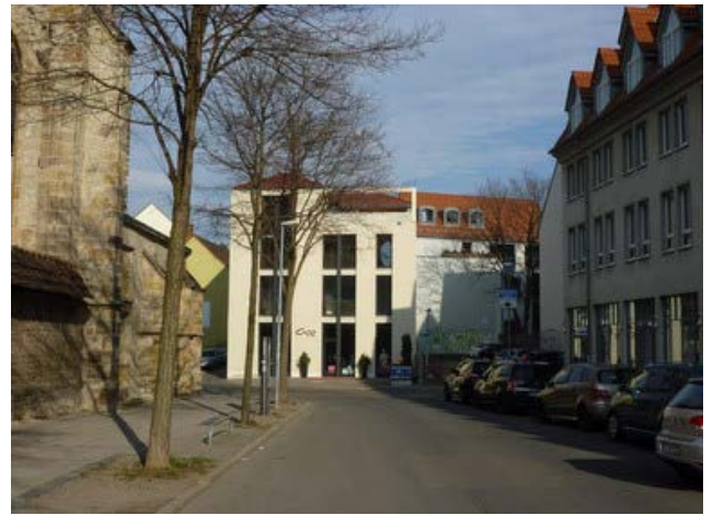
2020, links Kirche, Mitte Gebäude Taschengasse 4, rechts Hotel
