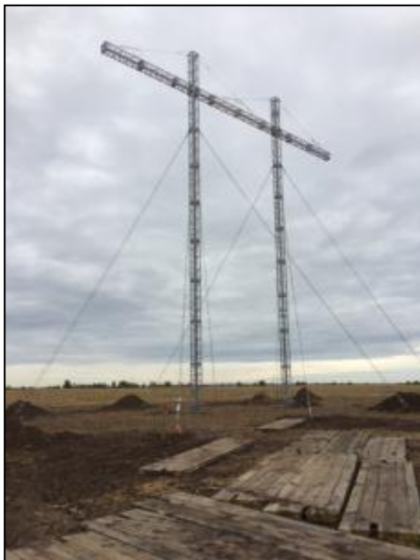
Abbildung 12: Provisorischer Mast mit Erdankern für die Aufnahme eines Systems (Quelle: 50Hertz)
