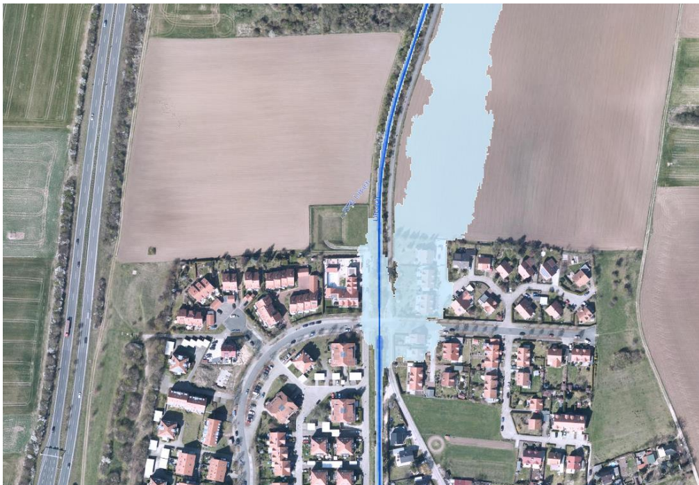
Bild1: Überflutungsbereich bei einem HQ100 am Durchlass
