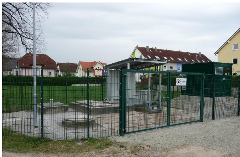
PW Linderbach: Fertigstellung der Netzersatzanlage (NEA)
