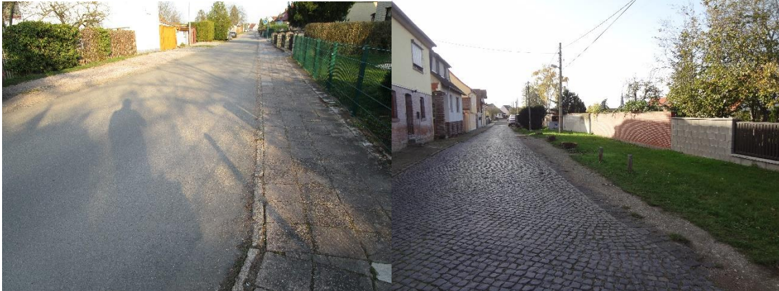
Blick in östliche Richtung
