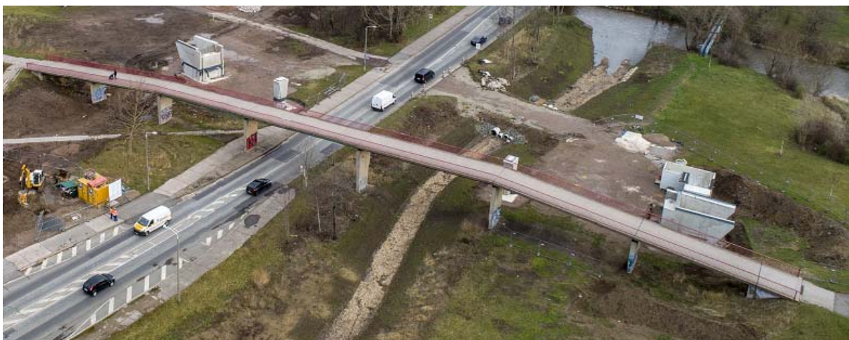
Abbildung 14 – im Vordergrund die Bestandsbrücke über die NQV, daneben die neuen Brückenpfeiler
