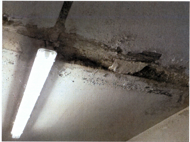
Foto 4, Decke Elektroraum, bereitgestellt 02/2020
