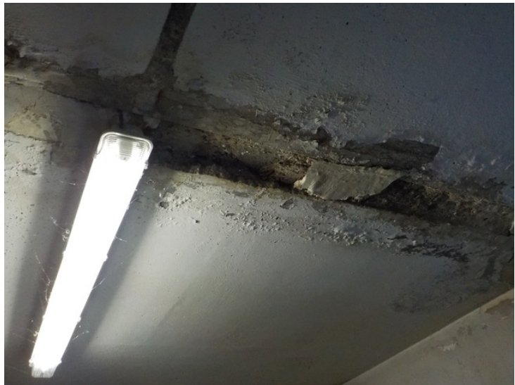
Foto 4, Decke Elektroraum, bereitgestellt 02/2020
