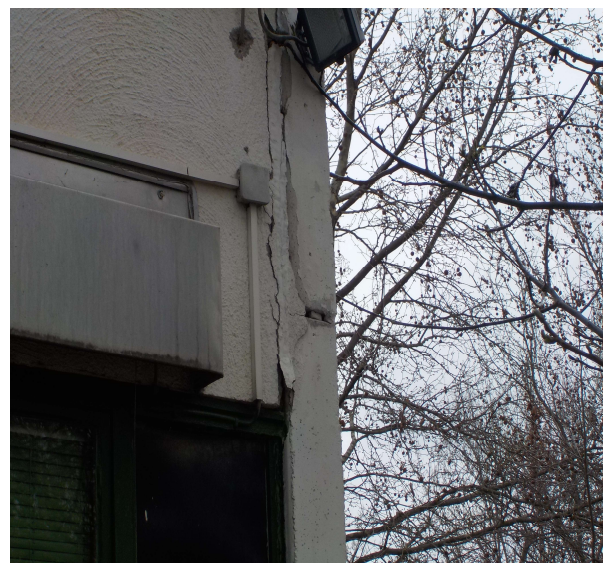
Foto 3, Außenwand Gartenseite, bereitgestellt 02/2020
