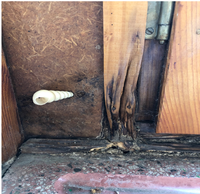
Foto 1: Fenster im Waschraum, 1. OG links, aufgenommen 02/2020
