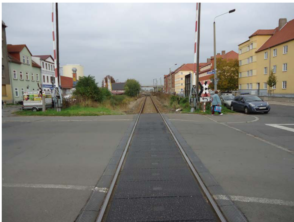
Bild 2: Blickrichtung Nordwest, Richtung Bf Erfurt-Nord
