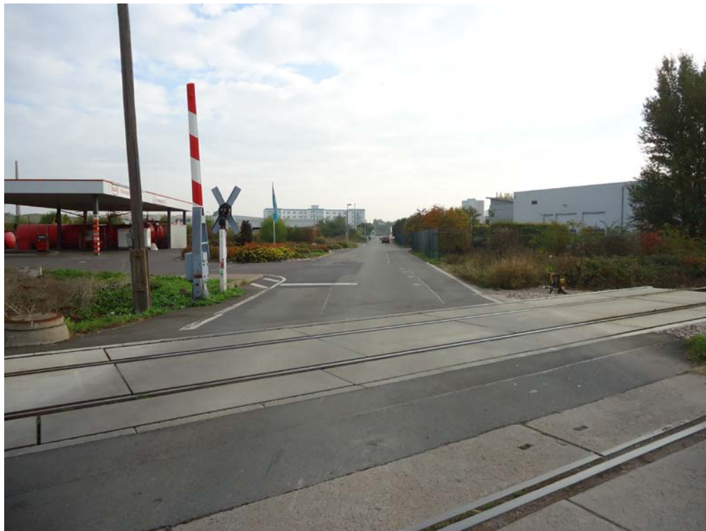
Bild 3: Blickrichtung Ost, in Richtung August-Röbling-Straße
