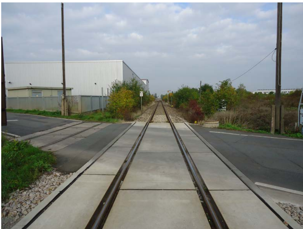
Bild 2: Blickrichtung Nordwest, Richtung Bf Gispersleben
