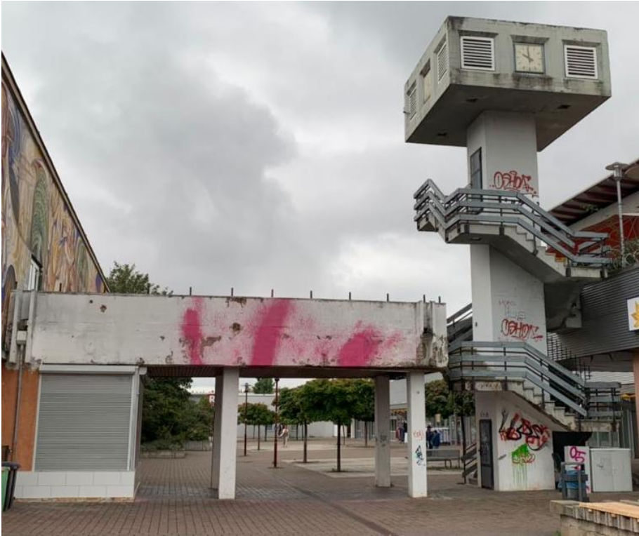
DS 1874/20 - Anlage 1_Foto Gebäude Mainzer Straße 35 am Platz der Völkerfreundschaft
